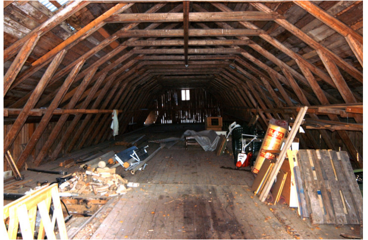
Loftet før nyinnredning. Foto: Anne Sætren, NIKU 2008.
