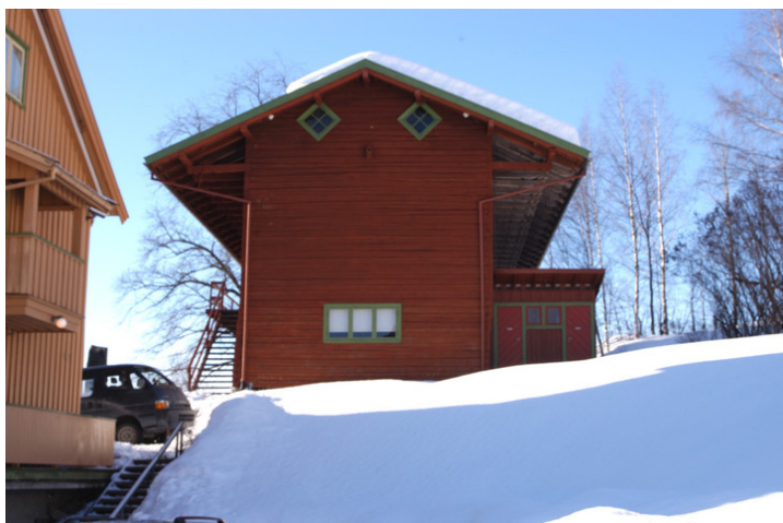
Fasade øst Foto: Anne Sætren, NIKU 2008
