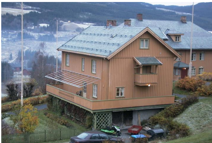
Drengstua nord og østfasader 2004. Foto: Bjørn Mølmen. Opphavsrett: Bjørn Mølmen.
