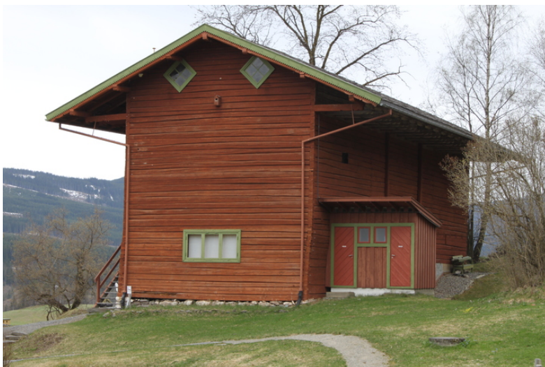
Sett fra nordøst. Tilbygget t.h. er fra 1959 og inngår ikke i fredningen. Foto: J. Chr. Eldal, NIKU, 2012.
