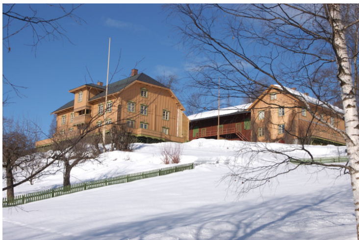
Fasader sør og øst. Foto: Anne Sætren, NIKU 2008
