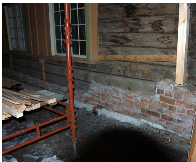
Eldre utbedring av råteskadet svill. Foto: Anne Sætren, NIKU 2008
