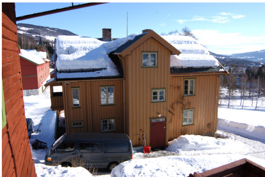
Drengstuas vestfasade. Foto: Anne Sætren, NIKU 2008.
