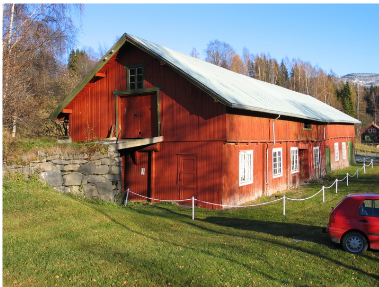
Folkestua før rehabiliteringsarbeidene startet opp. Foto: Maihaugen 2005.
