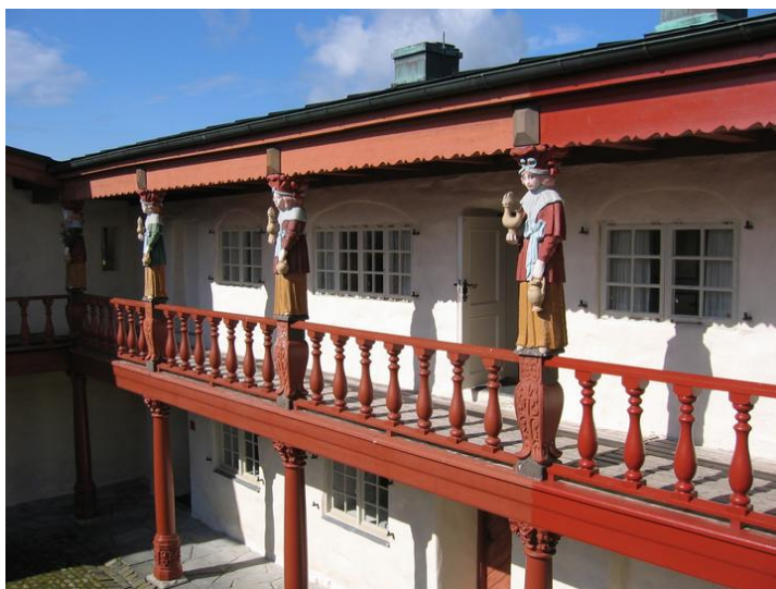
Vestfløy med karyatider. Opphavsrett: Statsbygg.
