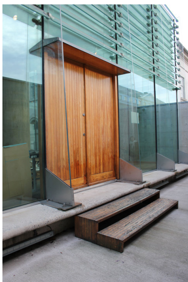
Fehn paviljongen, inngangsdør mot syd Foto: Ingrid Melgård, Riksantikvaren Opphavsrett: Riksantikvaren
