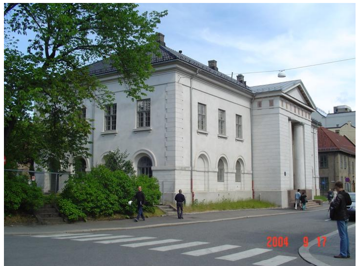
Bildet tatt i Norvestlig retning og viser hovedfløyen østlige fasade Foto: Erik Ruud Opphavsrett: statsbygg
