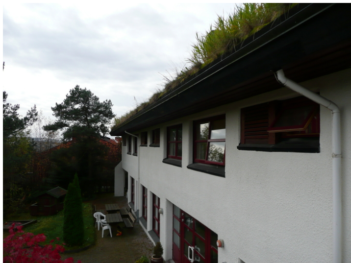
Fasade mot øst. Opphavsrett: Statsbygg.
