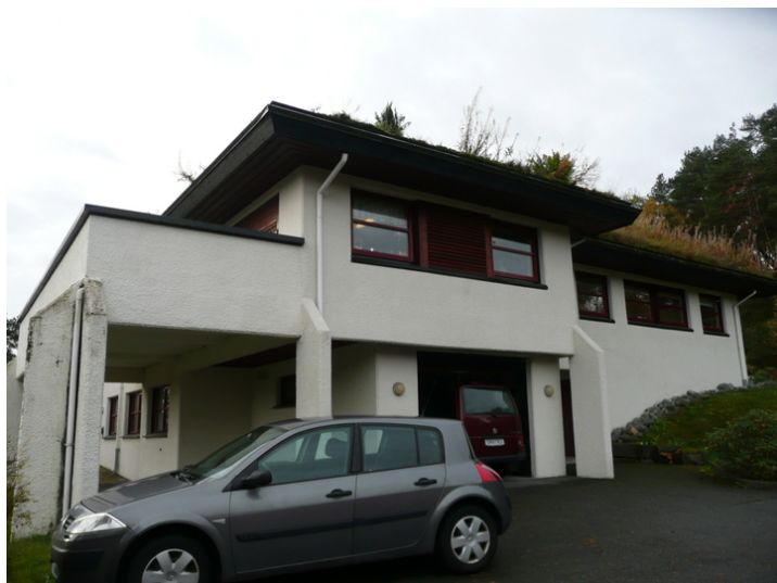
Fasade mot nord. Opphavsrett: Statsbygg.
