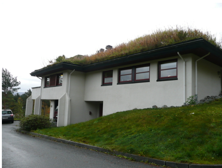
Fasade mot nord. Opphavsrett: Statsbygg.
