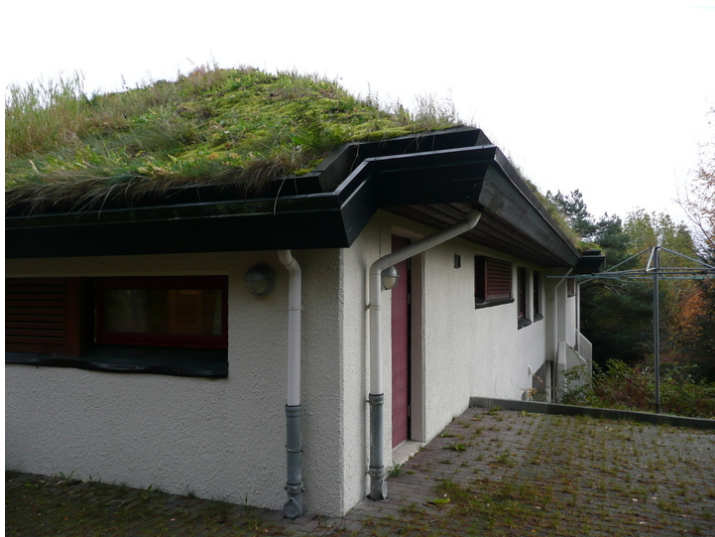
Fasade mot sør til høyre. Opphavsrett: Statsbygg.
