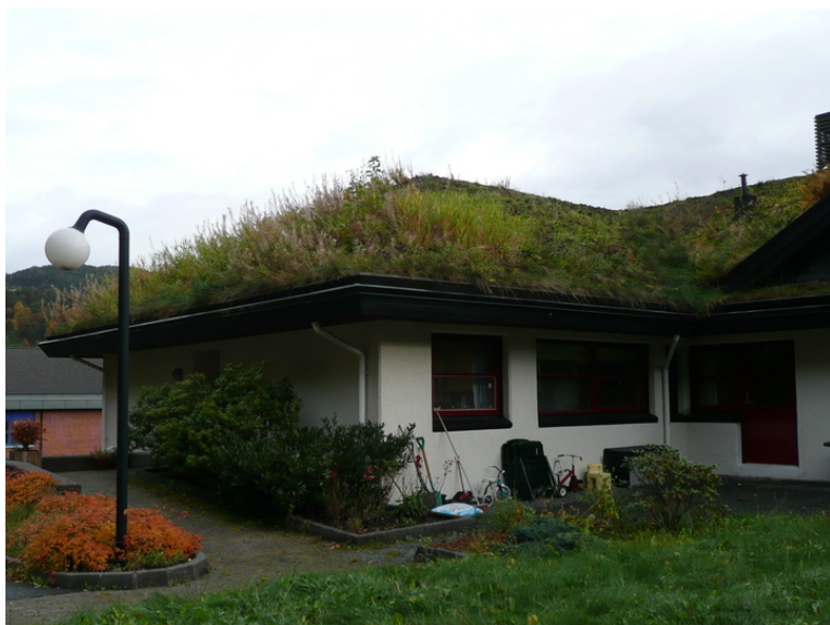
Bygningens U-form og sprang i fasadene gir usjenerte uterom. Opphavsrett: Statsbygg.
