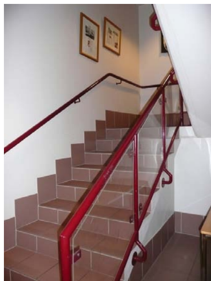
Trapp fra inngangshall i 1. etg til 2. etg. Opphavsrett: Statsbygg.
