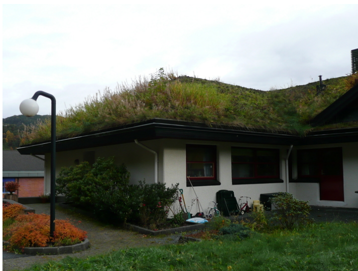
Fløy administrasjon (nordligste fløy). Opphavsrett: Statsbygg.
