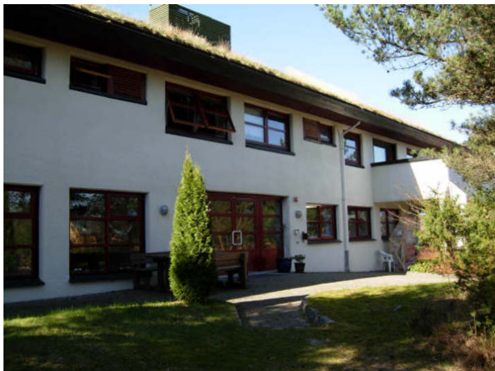
Fasade mot øst. Opphavsrett: Statsbygg.
