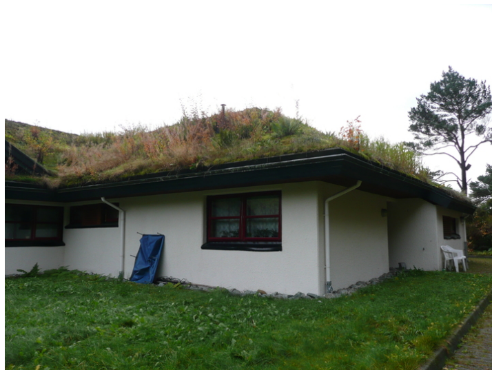
Fløy sørvest. Opphavsrett: Statsbygg.
