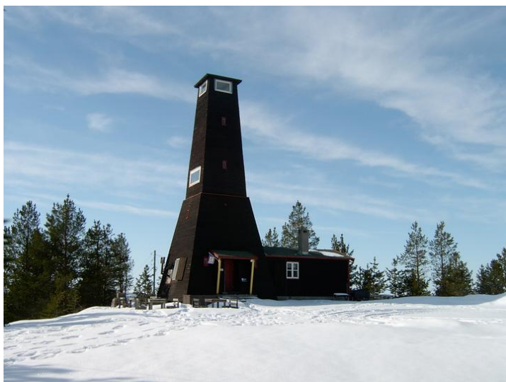
Fasade nord Foto: Håkon Skarstad
