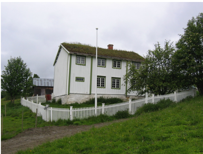
Hagen er gjerdet inn. Gjerdet følger omtrent eiendomsgrensen. Opphavsrett: Statsbygg.
