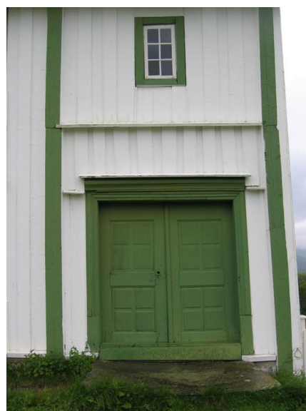
Innadslående tofløyet hoveddør leder inn til trappegang og til stue og kjøkken. Opphavsrett: Statsbygg.
