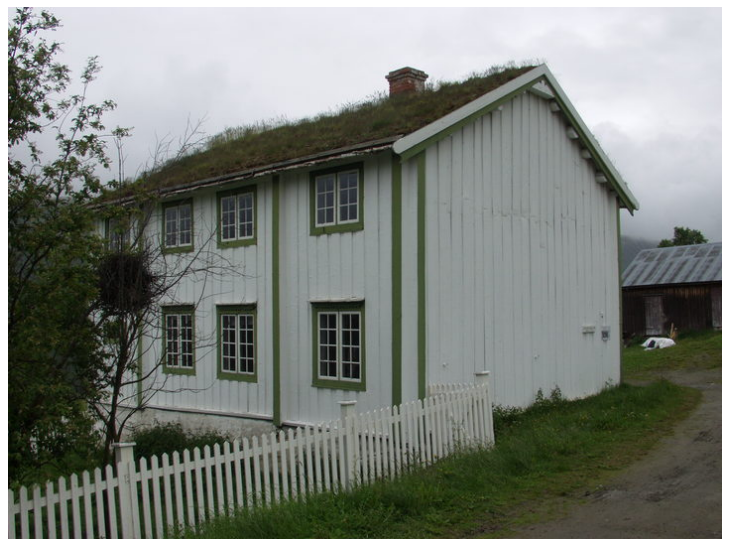
Veien til høyre går gjennom det som tidligere var et komplett gårdstun. Opphavsrett: Statsbygg.
