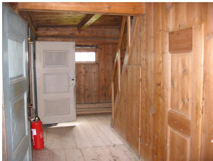
Trappegang sett fra inngangsdør. Opphavsrett: Statsbygg.
