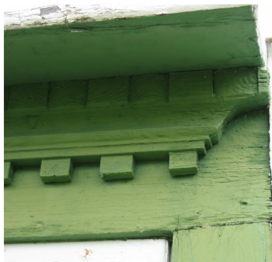
Detalj fra vindu. Original utvendig belistning med tannsnitt under vannbrett. Opphavsrett: Statsbygg.
