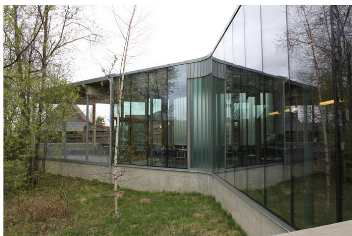
Vestfasaden sett mot nord fra betongrampen. Foto: J. Chr. Eldal, NIKU, 2012.
