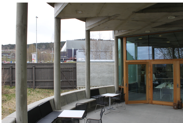
Nordre tverrarms veranda sett mot øst. Betongbenken t.v. fortsetter i kafeen innenfor. Foto: J. Chr. Eldal, NIKU, 2012.
