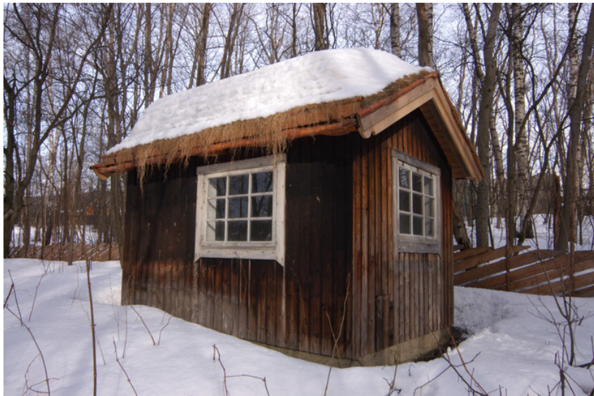
Hønehuset med nytt tak 2008 Foto: Anne Sætren, NIKU 2008.
