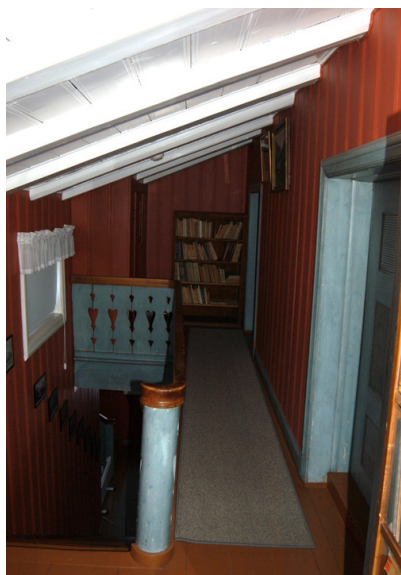
Svalen i andre etasje. Foto: Anne Sætren, NIKU 2008.
