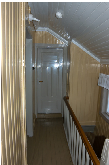
Trappegangen i 2.etasje Foto: Anne Sætren, NIKU 2008.
