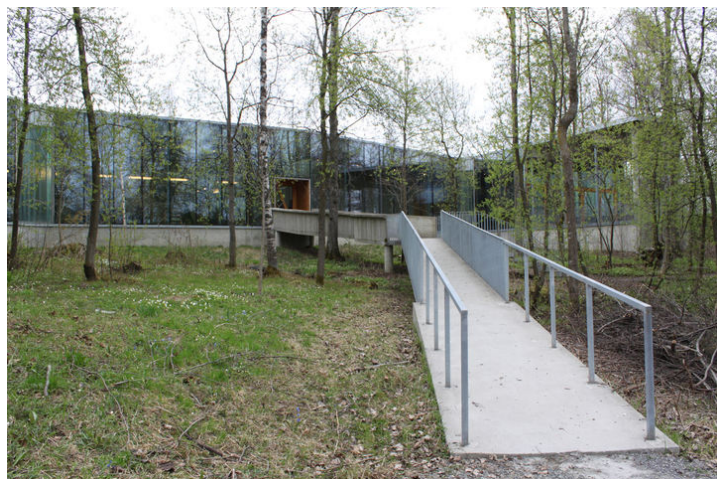
Nedre del av rampen sett mot vest og opp mot bygget. Foto: J. Chr. Eldal, NIKU, 2012.
