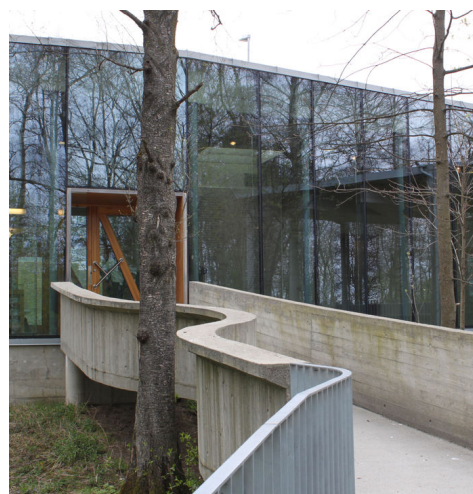
Betongrampen på vestsiden som forbinder bygget med Sigrid Undseths anlegg. Hele rampen inngår i fredningen. Foto: J. Chr. Eldal, NIKU, 2012.
