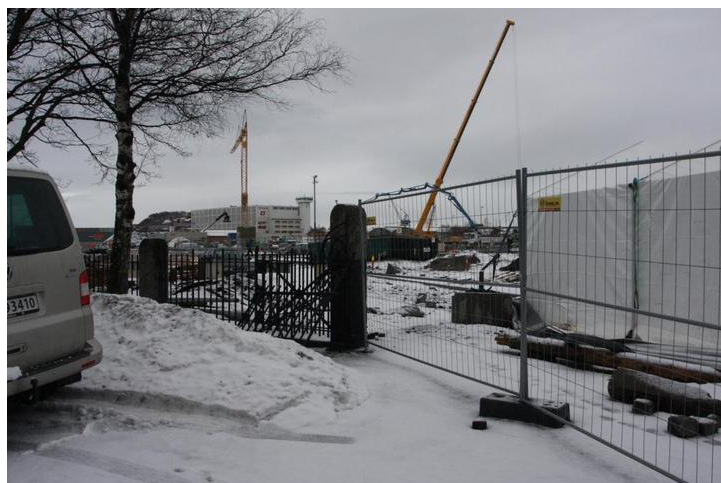
Opprinnelig gjerde delvis demontert for veiarbeid. Opphavsrett: Entra.
