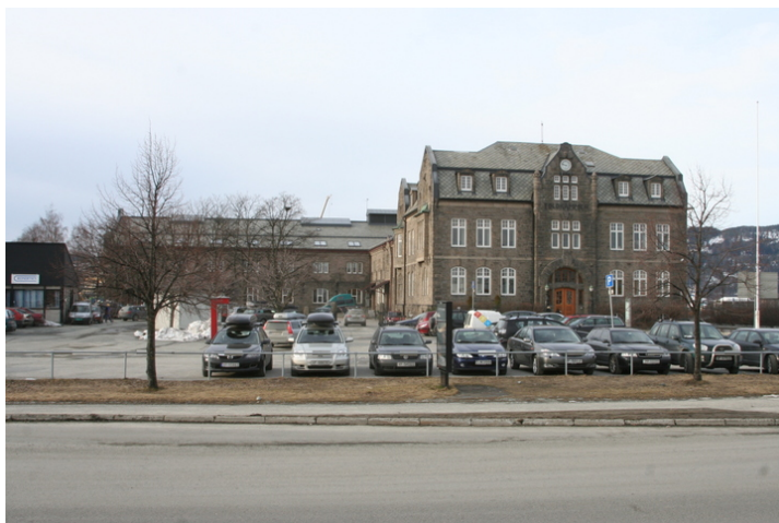
Sett fra nordøst med hovedbygningens hovedfasade. Foto: J. Chr. Eldal, NIKU 2008.
