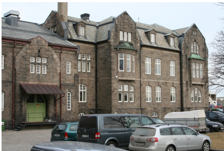
Del av pakkhus og hovedbygningen sett fra syd. Foto: J. Chr. Eldal, NIKU 2008.
