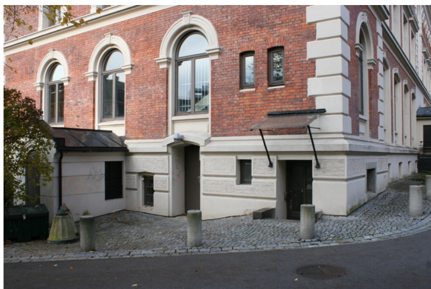
Sydvestre kortvegg med fra venstre: Nyere tilbygg for tekn. installasjon, inngang til baktrapp og inngang til kjeller. Foto: J. Chr. Eldal, NIKU 2008.
