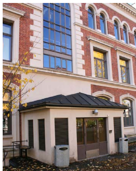
Inngangstilbygg fra 1960 på gårdsfasaden. Foto: J. Chr. Eldal, NIKU 2008.
