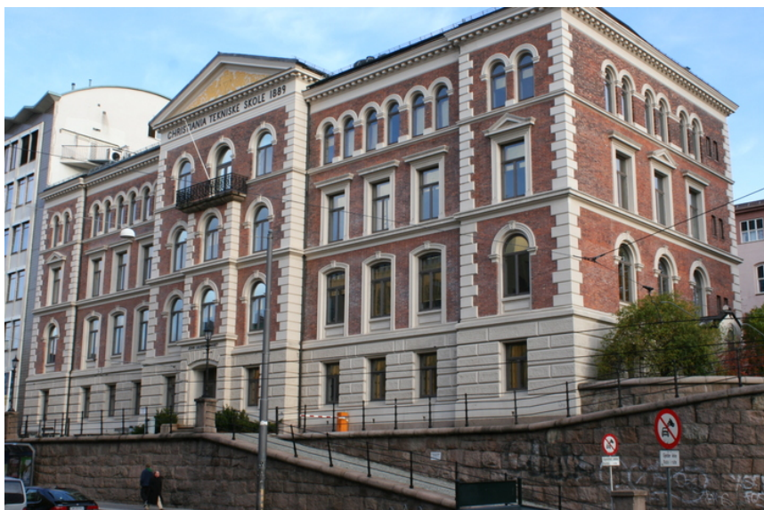
Sett fra syd. Foto: Eldste del fra 1889:
