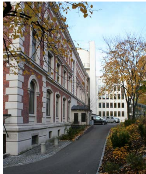
Gårdsrommet sett fra sydøst. Lite glassbygg med rømningsvei fra auditorier under gårds plass skimtes blant vegetasjonen t.h. Foto: J. Chr. Eldal, NIKU 2008.
