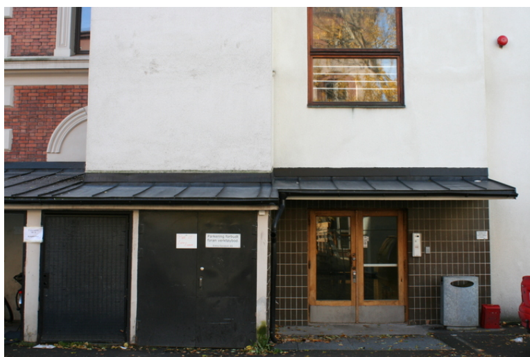
Inngang til hovedtrapp fra gårdsiden. Foto: J. Chr. Eldal, NIKU 2008.
