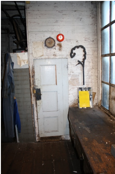
FIGUR 95 MASKINVERKSTED ROM 2.5. DØR TIL FORMANNSKONTOR ROM 2.6.
