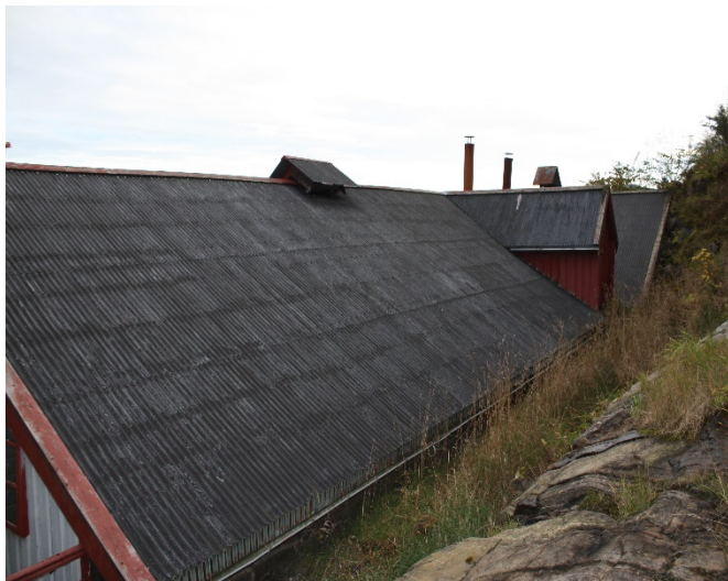
FIGUR 75 BYGNING NR. 2 VERKSTEDBYGGET. SETT MOT SØ. TAKUTSPRING MED INNGANG.
