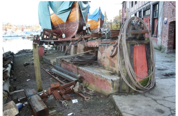
FIGUR 129 UTEAREAL NR. 12 SLIPP "MELLOMHÆLING". SLIPPHODET SETT FRA NORDRE SIDE, MED MIDTRENNE OG STYRBORD SLAGBEITE. KASTEBLOKK TIL UTHALERWIRE FESTE I SLIPPHODET. TREFENDRING FOR Å HINDRE SLITASJE PÅ WIRE.
