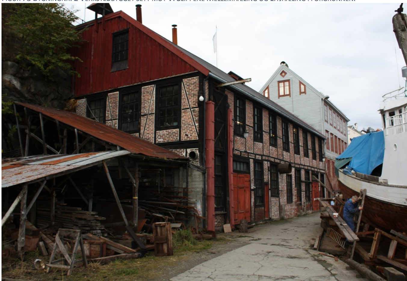
FIGUR 74 BYGNINGNR. 2 VERKSTEDBYGGET SETT MOT NV. SLIPP LITJHÆLING T.H. KLOKKETÅRN I GAVLEN.
