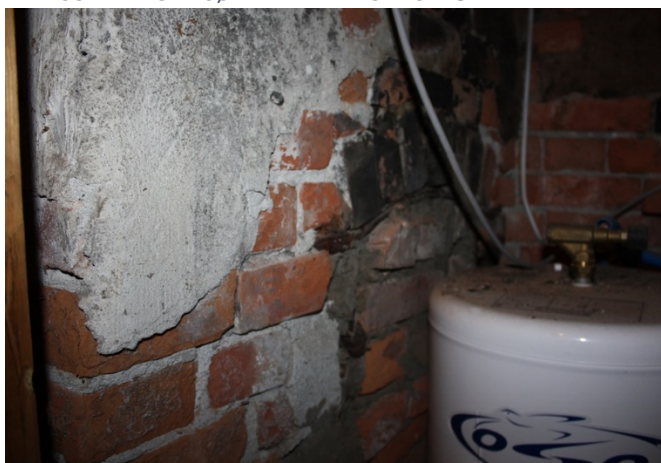
FIGUR 21 BYGNING NR. 1 HOVEDBYGNING. PIPEROM 2.7 GJENMURT BAKEROVNÅPNING. SELVE BAKEROVNEN ER FJERNET.
