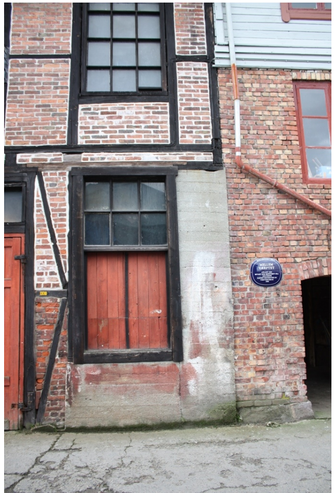
FIGUR 80 BYGNINGNR. 2 VERKSTEDBYGNINGEN. NORDRE ENDE SAMMENBYGD MED BYGNING 1 HOVEDHUSET. BETONG ERSTATTER BINDINGSVERKET.
