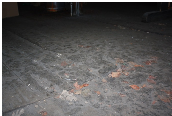
FIGUR 104 ROM 3.1 RIGGELOFT. TYKKE LAG AV BEK OG HAMPEFIBER PÅ GULVET ETTER RIGGEARBEID.
