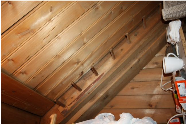
FIGUR 67 BYGNING NR. 1 HOVEDHUSET ROM 5.2 GANG. INTERIØR BOD, ALLE BODENE UTSYRT LIKT MED FORSEGGJORTE KNAGGEREKKER I SAMME UTFØRELSE.
