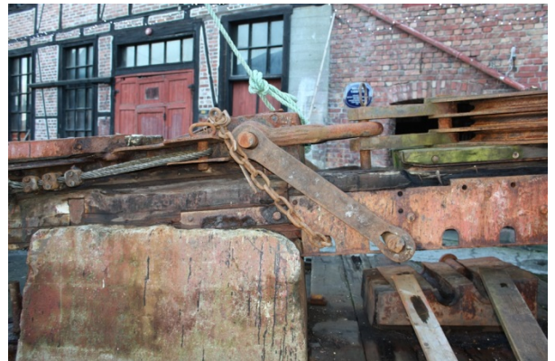
FIGUR 131 UTEAREAL NR. 12 SLIPP "MELLOMHÆLING". LÅSING AV SLIPVAGNA TIL MIDTRENNE MED "BRILLER", DVS. EN LENGDE MED FLATJERN MED ØYE I HVER ENDE SOM SMETTER OVER KRAFTIGE JERNSTANG LENGDER.
