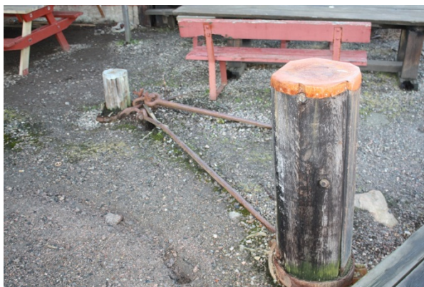
FIGUR 117 UTEAREAL NR. 7 MELLOMKAIA - FORTØYNINGSPÅLER. SØNDRE PÅLE MED STAG/BESLAG.
