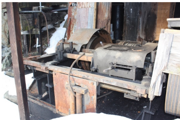
FIGUR 114 BYGNING 6 VINSJSKURET. VINSJEN. WIREN I FRAMKANT GÅR TIL SLIPPENE.
