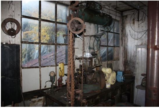
FIGUR 93 MASKINVERKSTED ROM 2.5. VEGG MOT S MED VEGGFAST ARBEIDSBENK OG TRYKKLUFTSBEHOLDER PÅ VEGGEN.
