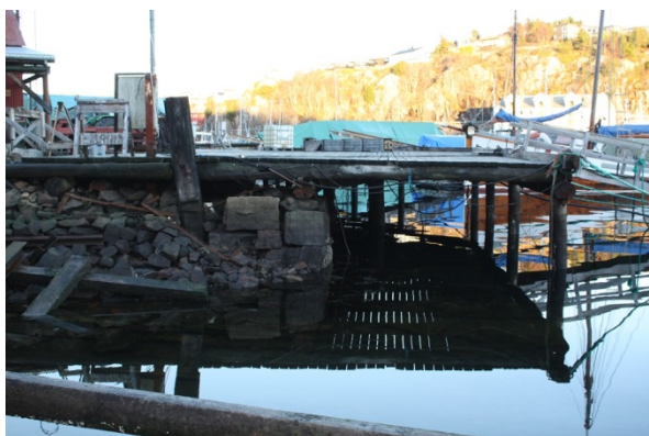
FIGUR 120 UTEAREAL NR. 8 MELLOMKAIA - KAIFRONT/DEKKE. KAIFRONT AV STEIN SES UNDER TREKONSTRUKSJONEN, MED BREMSEPÅLE I BAKKANT AV STEINSETNING OG FORANKRET I DENNE. TREKAIA FORNYET PÅ 1980-TALLET, VESENTLIG DELER AV DEN OPPRINNELIGE UNDERLIGGENDE KONSTRUKSJON BEVA
