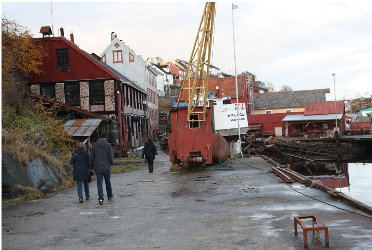
FIGUR 134 UTEAREAL NR. 14 SMIKAIA. BETONGDEKKE, NATURSTEIN I KAIFRON MED TREFENDRING. OFFENTLIG GANGVEI GJENNOM VERFTET. KRAN NR. 16 MIDT PÅ BILDET.
