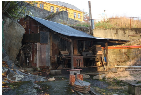
FIGUR 125 STEAMRENNE UTEAREAL NR. 10 I RELASJON TIL BYGNINGNR. 6 VINSJHUSET. ØVERSTE TALJE TIL UTEAREAL NR. 11 SLIPP STORHÆLING I FORGRUNNEN.
