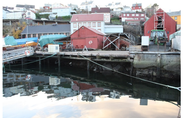
FIGUR 123 UTEAREAL NR. 9 TØMMERDOKK. TREKAI OVER DEN GJENFYLTE TØMMERDOKKEN, FYLLMASSE SYNLIG UNDER. T.H. FRONTEN AV UTEAREAL NR. 17, BEKHUSKAIA.
