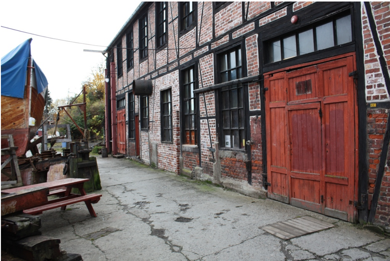
FIGUR 81 BYGNINGNR. 2 VERKSTEDBYGNINGEN. FASADEN MOT ØST. SLIPPEN "LITJHÆLING" T.V.
