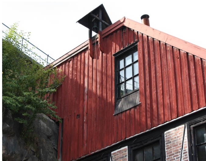
FIGUR 76 BYGNING NR. 2 VERKSTEDBYGGET. GAVLEN I S MED KLOKKETÅRN. TIDLIGERE INNGANG I OMRÅDET MELLOM BERGET OG VINDUET.
