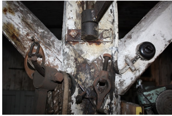
FIGUR 94 MASKINVERKSTED ROM 2.5. DETALJ AV BÆRESTOLPE, SEKUNDÆRT BRUKT SKIPSMAST, MED SPOR ETTER ***.
