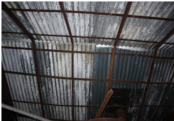
FIGUR 113 BYGNING 6 VINSJSKURET. TAKKONSTRUKSJON FRA INNSIDEN.
