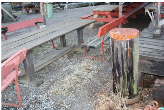
FIGUR 118 UTEAREAL NR. 7 MELLOMKAIA - FORTØYNINGSPÅLER. NORDRE PÅLE MED STANG/BESLAG.
