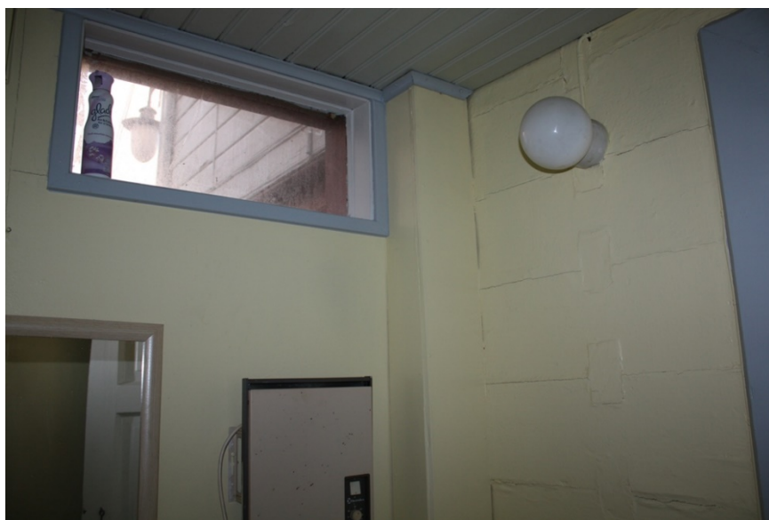
FIGUR 32 ROM 3.8 TOALETT. SETT MOT NØ.
