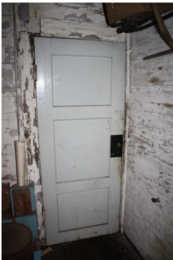
FIGUR 97 MASKINVERKSTED DØR TIL TAVLEROM 2.7.
