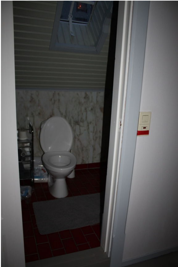
FIGUR 68 BYGNING NR. 1 HOVEDHUSET ROM 5.3 BAD/WC. SETT MOT V. TAKLUKE SOM VINDU.
