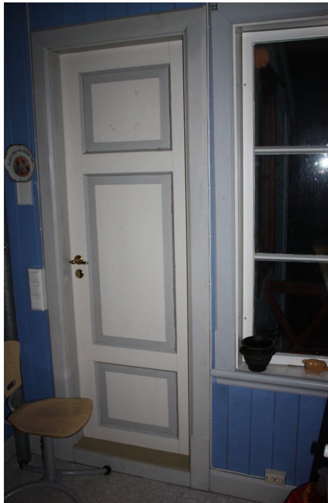
FIGUR 61 BYGNING NR. 1 HOVEDHUSET ROM 4.10 WC DØR FRA ROM 4.0 KJØKKEN TIL WC 4.10.
