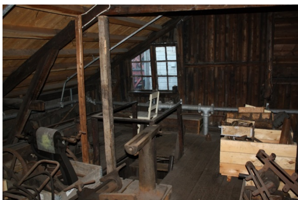
FIGUR 105 ROM 3.1 RIGGELOFT. SETT MOT NV. GELENDER RUNDT TRAPP NED TIL MOTORROM 2.*
