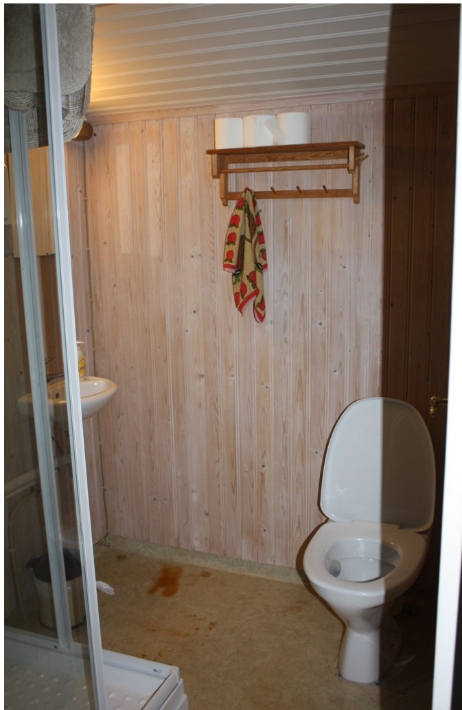
FIGUR 60 BYGNING NR. 1 HOVEDHUSET ROM 4.10 WC SETT MOT SV.
