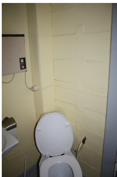
FIGUR 31 ROM 3.8 TOALETT. SETT MOT NØ.
