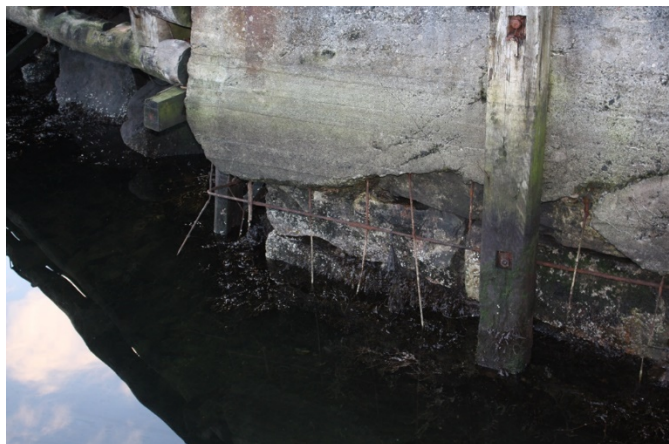
FIGUR 145 UTEAREAL NR. 17 KAI BEKHUSKAIA. DETALJ FASADEN. BETONG STØPT UTENPÅ NATURSTEINKAI.
