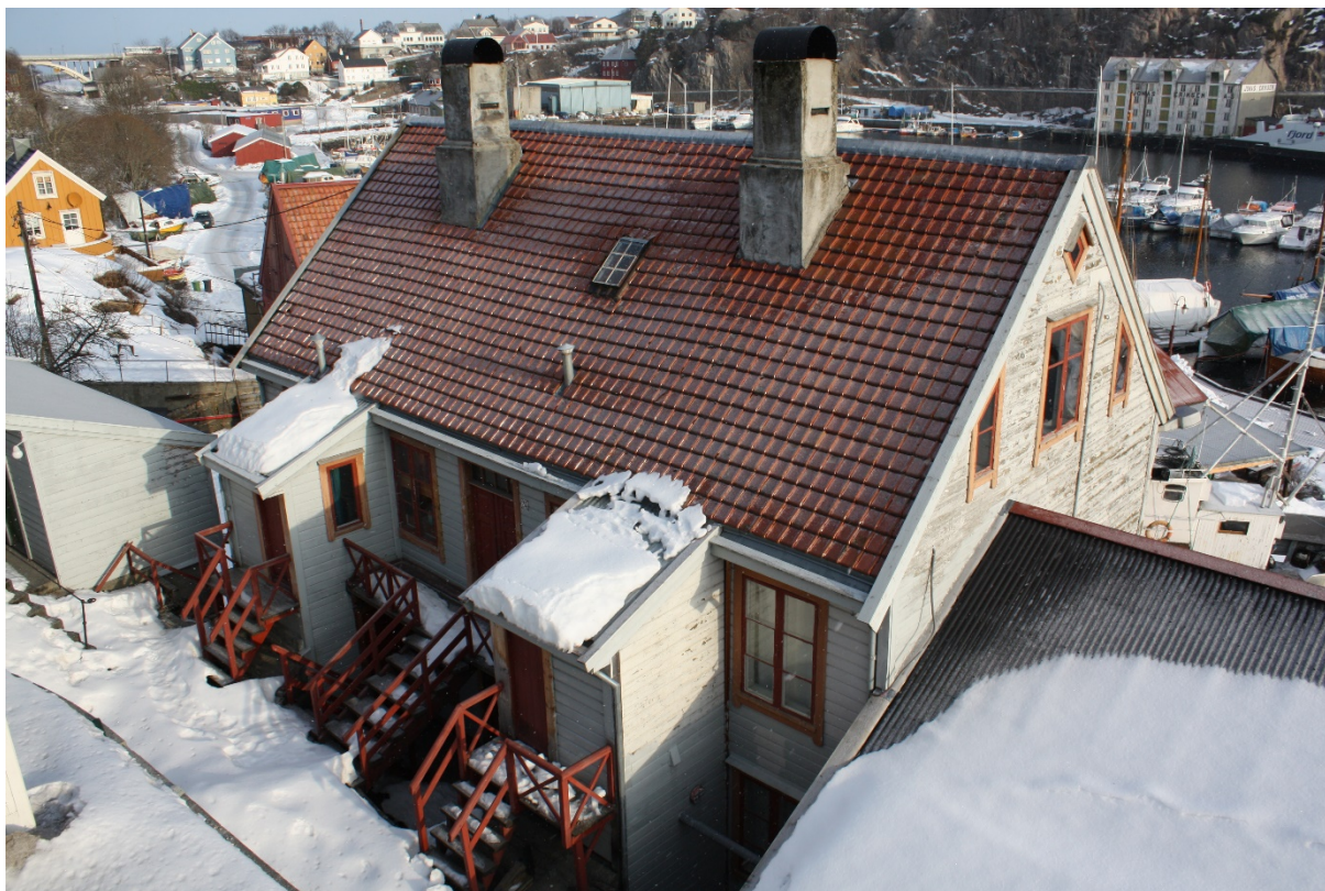
FIGUR 6 BYGNING NR. 1 HOVEDHUSET. Ø-VEGG MED INNGANGER TIL LEILIGHETER.
