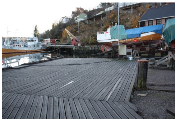
FIGUR 119 UTEAREAL NR. 7 MELLOMKAIA - FORTØYNINGSPÅLER. SØNDRE PÅLE RELATERT TIL SØNDRE HALVDEL AV MELLOMKAIA. STOPPEPÅLEN I ENDEN AV KAIA. SMIAKAIA I BAKGRUNNEN.
