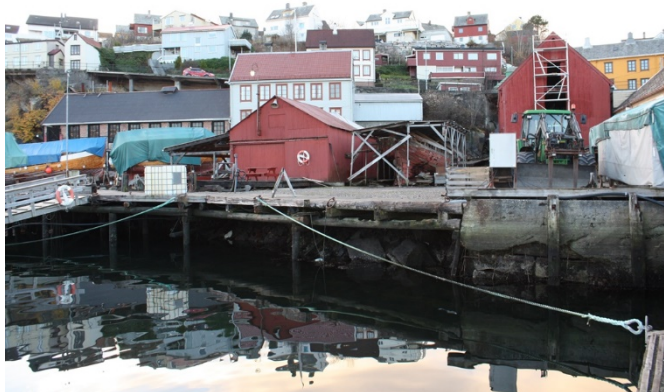
FIGUR 144 UTEAREAL NR. 17 KAI BEKHUSKAIA. SETT MOT V. TØMMERDOKK T.V. BEKHUSKAIA T.H.
