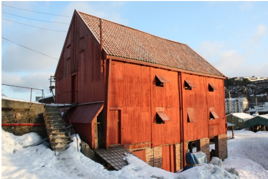
FIGUR 108 BYGNING 5 MATERIALBRYGGA SETT FRA NV. TRAPP AV BETONG OPP TIL INNGANG TLL 3. ETASJE OG OPPGANG TIL VEIEN. HALVTAK PÅ GAVLEN TIL GANGSPILLSPIRER.
