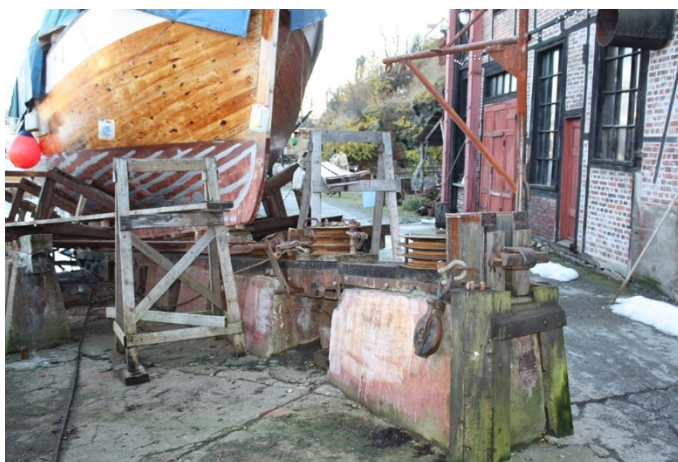
FIGUR 132 UTEAREAL NR. 13 SLIPP "LITJHÆLING". SETT MOT SV. HODET PÅ SLIPPEN MED BLOKKER. TREFENDRING FOR Å HINDRE SLITASJE PÅ WIRE. FUNDAMENT AV BETONG OG STEIN. VOGN MED BEVEGELIGE BUKKER SOM STØTTER BÅTEN PÅ SLIPP.
