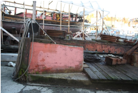
FIGUR 128 UTEAREAL NR. 12 SLIPP "MELLOMHÆLING". SLIPPHODET. T.H. HODET PÅ "VOGNS" SOM GLIR PÅ SLISKEN OG SLAGBEITENE (SIDEBANENE). TREPLATTING SOM SLITELAG; BLOKK MED FESTE LØSNES FRA VOGNA OG LØFTES NED. I BAKGRUNNEN, BÅT PÅ SLIP UTEAREAL NR. 11 "STORHÆLING".
