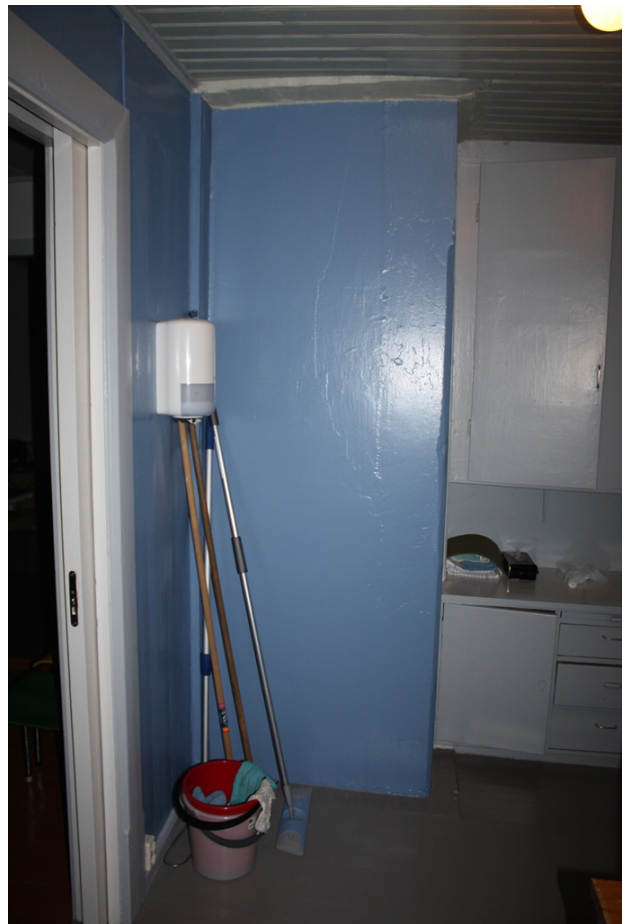
FIGUR 40 BYGNING NR. 1 HOVEDHUSET. KJØKKEN 4.2 SETT MOT NØ. MALT PIPE.
