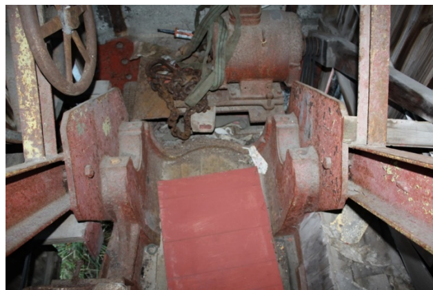
FIGUR 141 UTEAREAL NR. 16 KRAN. INNSIDEN, FUNDAMENT FOR SKYTS.
