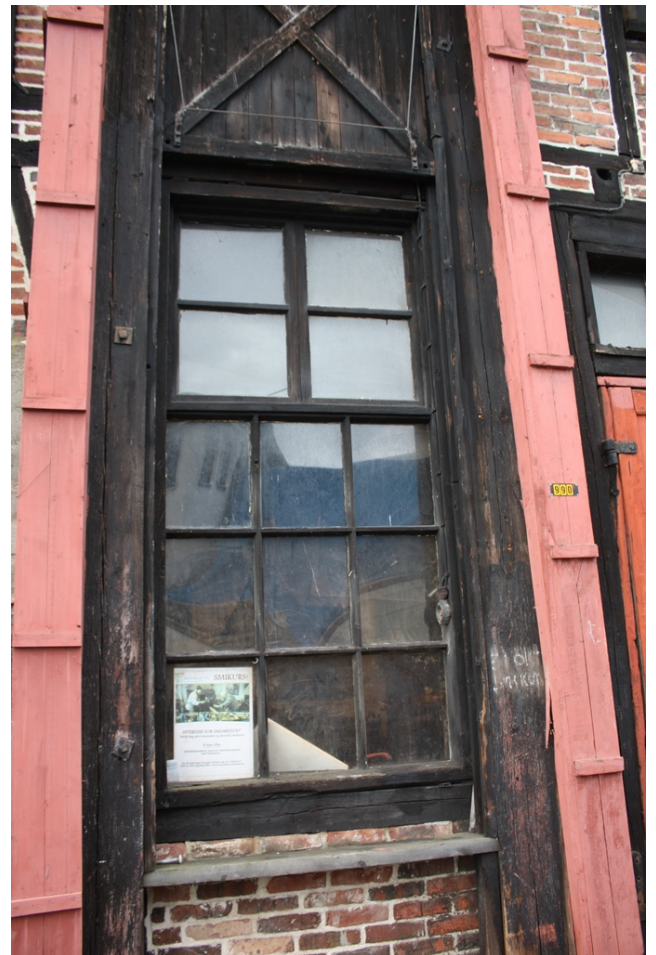
FIGUR 78 BYGNINGNR. 2 VEKSTEDBYGNINGEN. VINDU TIL SMIE, ROM 1.1. LODDKASSER PÅ HVER SIDE AV VINDUET TIL SKYVEDØR INNTIL 2. ETASJE. NEDERSTE DEL AV SKYVEDØREN SES I ØVRE BILDEKANT.
