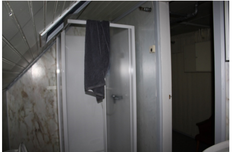
FIGUR 69 BYGNING NR. 1 HOVEDHUSET ROM 5.3 BAD/WC SETT MOT N.
