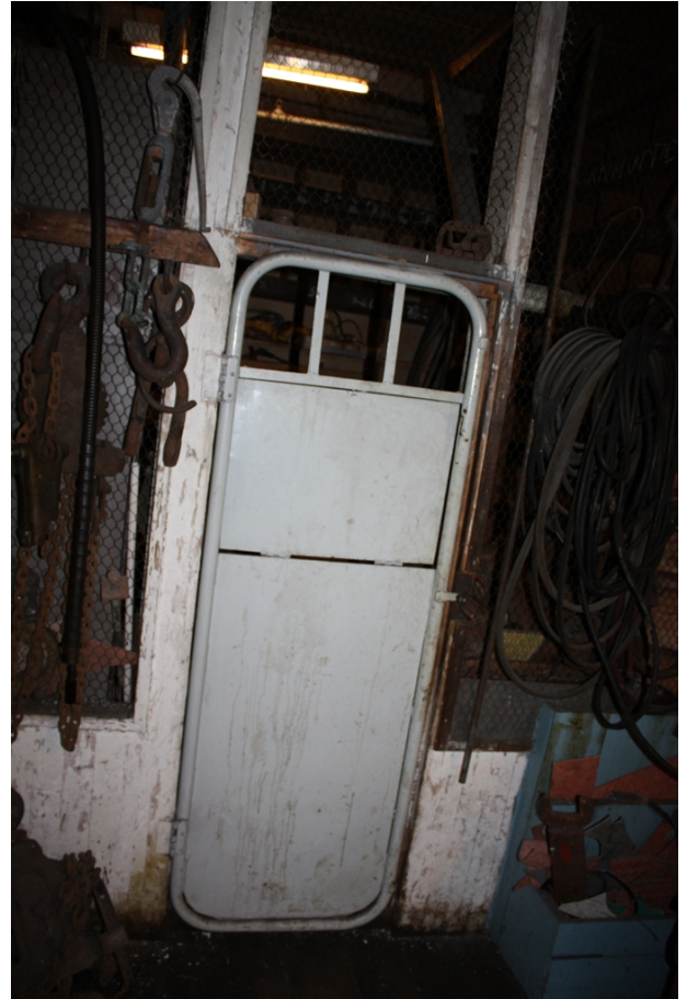
FIGUR 100 MASKINVERKSTED ROM 2.5. DØR TIL SKRUELAGER ROM 2.8. DØR LAGET AV SEKUNDÆRT BRUKT SYKEBÅRE.
