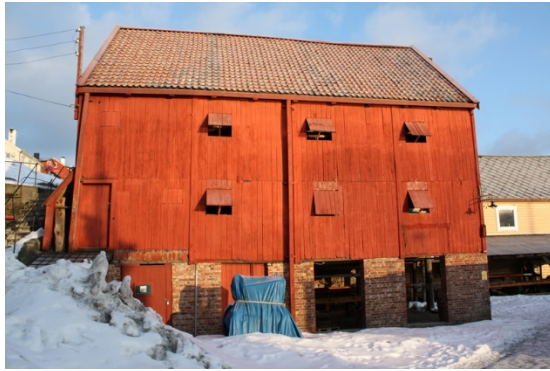
FIGUR 109 BYGNING 5 MATERIALBRYGGA SETT FRA S. INNGANG TIL 2. ETASJE T.V. LUKER TIL LUFFTING.
