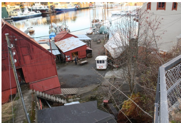
FIGUR 115 BYGNING 6 VINSJSKURET I FRAMKANT. MATERIALBRYGGA BYGNING * T.V., STORHÆLING NR. * T.H. FOR MIDTEN AV BILDET.
