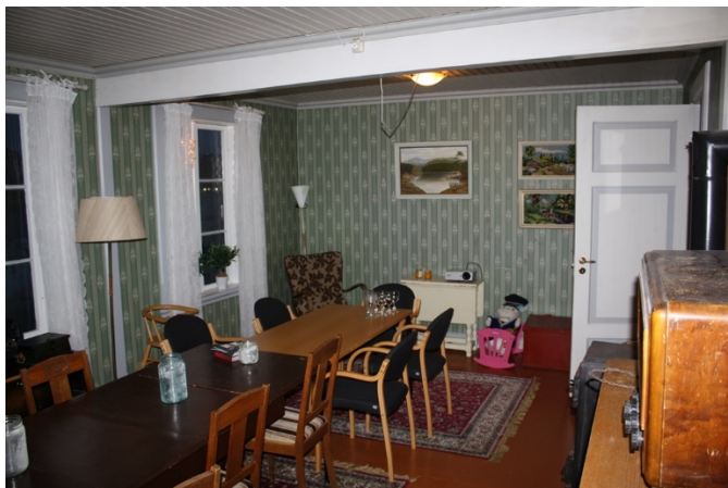
FIGUR 51 BYGNING NR. 1 HOVEDBYGNING ROM 4.6/4.7 STUE. SETT MOT SØ. BJELKE I TAKET ANGIR TIDLIGERE ROMSKILLE.
