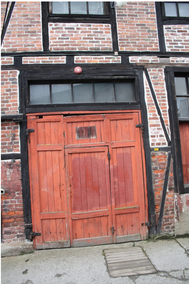
FIGUR 79 BYGNINGNR. 2 VERKSTEDBYGNINGEN. PORT INN TIL METALLSTØPERIET. LUKE I FORGRUNNEN GIR ADGANG TIL DRENERING UNDER BYGGET.
