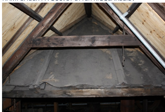
FIGUR 106 ROM 3.1. OPPRINNELIG TAKTEKKING FRA 187* SYNLIG OVER UTGANG MOT V.
