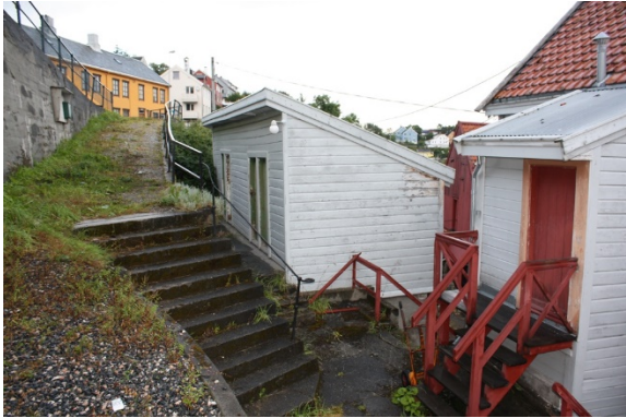
FIGUR 107 BYGNING 3 UTHUS. BISLAG TIL HOVEDHUSET T.H., TRAPP MED NEDGANG TIL VERFTSOMRÅDE MELLOM HOVEDHUSET OG UTHUSET. TRAPP OG OPPGANG TIL KRANAVEIEN T.V.
