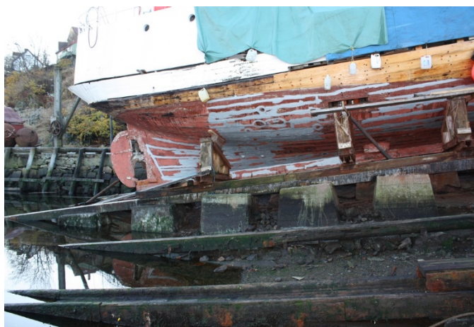
FIGUR 133 UTEAREAL NR. 13 SLIPP "LITJHÆLING". SETT MOT SV. STYRBORDBSIDE AV SLIPPEN. FUNDAMENTER UNDER SLAGBEITE DVS. SIDEBANEN.
