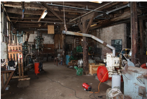
FIGUR 83 BYGNINGNR. 2 VERKSTEDBYGGET ROM 1.2. MOT SØR. STOLPENE AV AVKAPPET SKIPSMAST. PUTER UNDER DRAGER AV SKIPSSPANT AV EIK MED TRENAGLER I.
