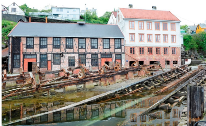
FIGUR 126 UTEAREAL NR. 11 SLIPP - STORHÆLING. I FORGRUNN STORHÆLING. MELLOM DEN OG VERKSTEDBYGNING ER MELLOMHÆLINGEN. STORHÆLINGEN ER BYGD SOM DE ELDRE SLIPPENE MED TØMREDE FUNDAMENTER, FESTET MED HAKER, SOM LIGGER SOM NATURSTEIN.
