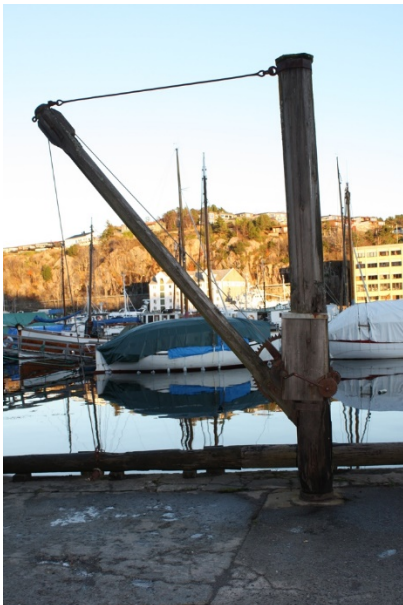
FIGUR 136 UTEAREAL NR. 15 KRAN.
