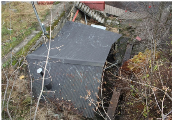
FIGUR 112 BYGNING 6 VINSJSKURET. SETT FRA KRANA VEIEN. STEAMRENNE * T.H.
