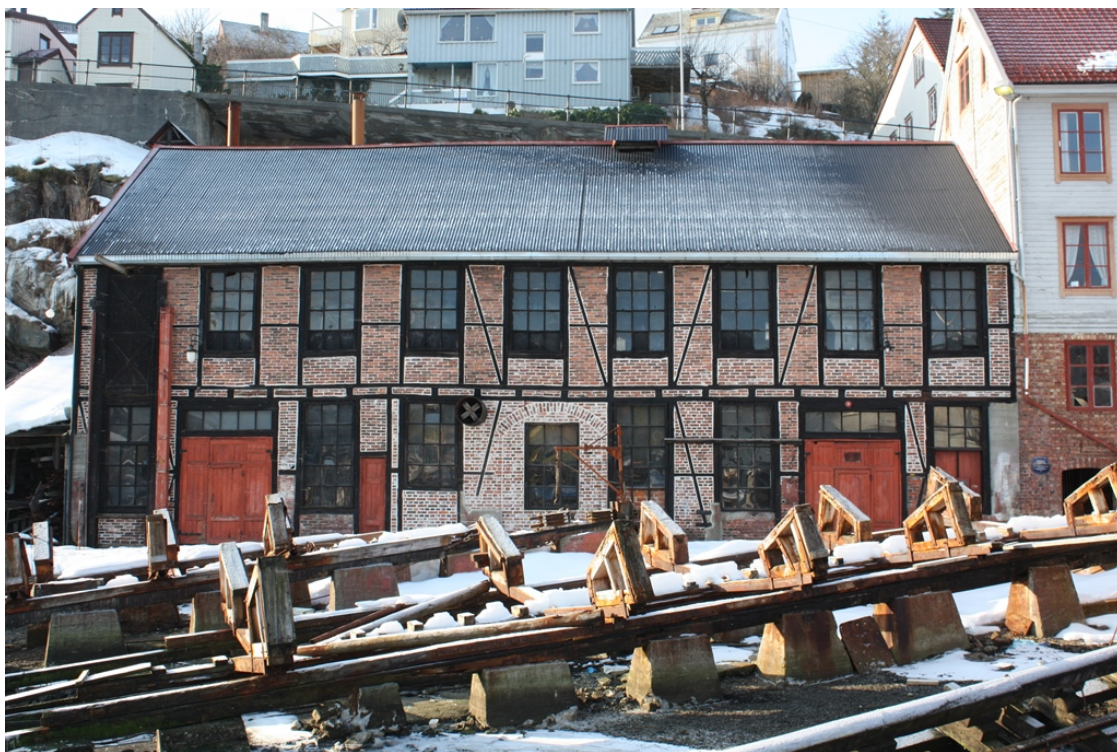
FIGUR 73 BYGNINGNR. 2 VERKSTEDBYGGET SETT MOT V. SLIPPENE MELLEMHÆLING OG LITJHÆLING I FORGRUNNEN.
