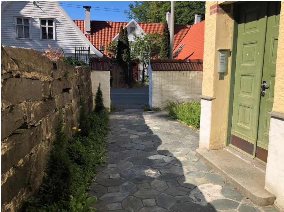
Mur sett frå gardsplassen. Detalj av dekke og inngangsparti.
