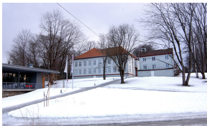
Nybygg og hovedanlegget sett fra nord Foto: Anne Sætren, NIKU 2008
