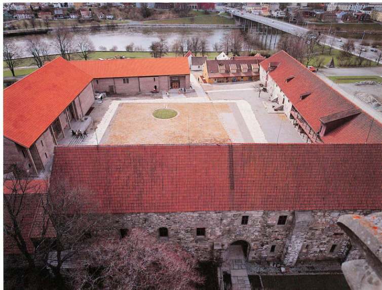
Sett mot syd fra domkirketårnet. Foto: Jiri Havran. Opphavsrett: Fra Statsbygg ferdigmelding 526/1997.
