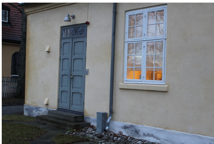
Inngangsdør i sydfasade. Døren er en nyere kopi, vinduet opprinnelig. Foto: J. Chr. Eldal, NIKU, 2014. Opphavsrett: jce
