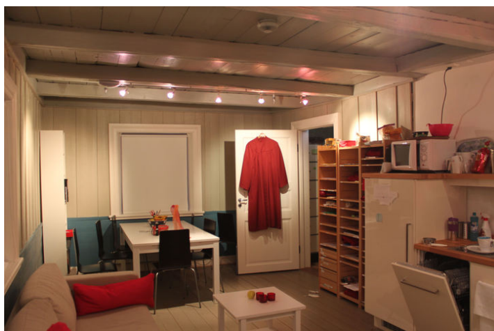
Hvilerommet med gammelt panel og bjelkehimling. Foto: J. Chr. Eldal, NIKU, 2014.
