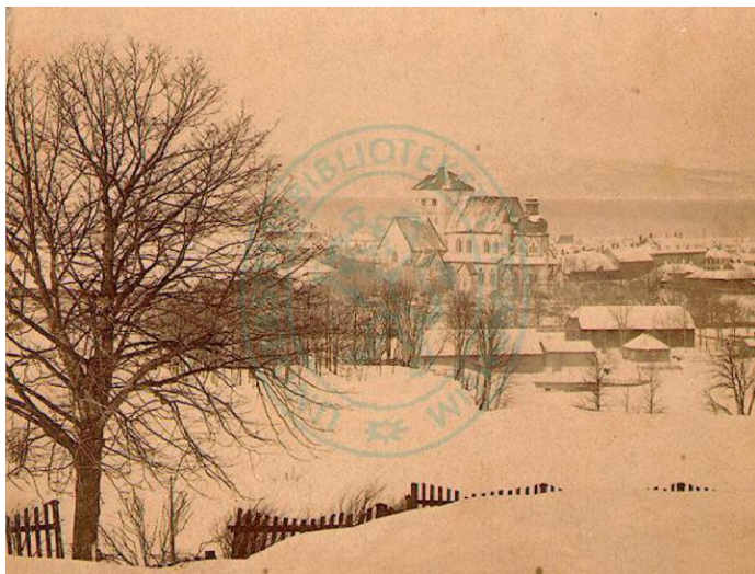
Marinen sett fra sydøst ca. 1870. Ingen vinduer i bygningens fasade mot elven. T.h. bygning med pyramidetak som ble ombygget og forlenget i 1930. Foto: M. W. Noodt. Opphavsrett: UBiT.
