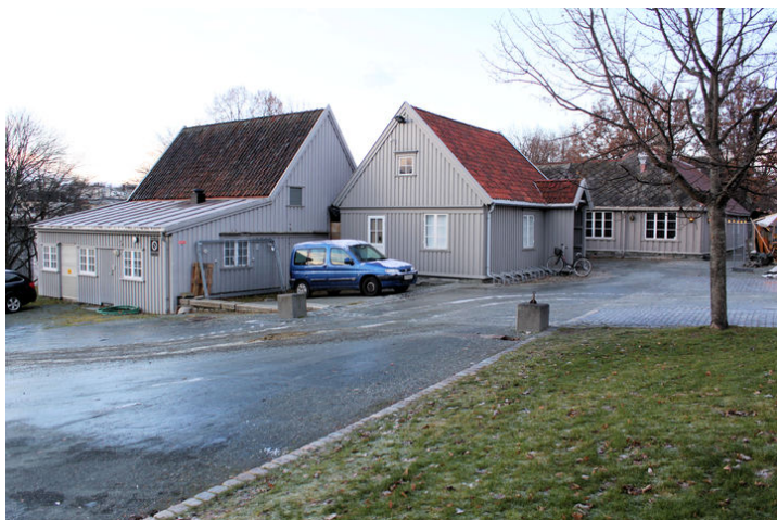
Sett fra nordøst. Bygningen midt i bildet er Vakthuset. Foto: J. Chr. Eldal, NIKU, 2014.
