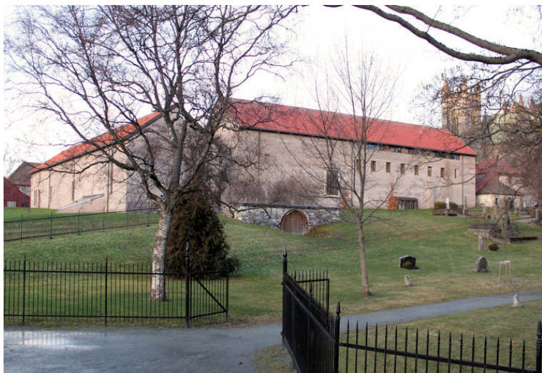
Sett mot nordvest. Midt i bildet kjellermurer fra ca. 1800 etter Søndre magasin som brant i 1983. Gjerdet i bakgr. t.v. går over Erkebispegårdens eiendom. Foto: J. Chr. Eldal, NIKU, 2014.
