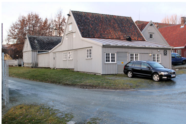
Sett fra sydøst med det tidl. sprøytehuset i forgr. Foto: J. Chr. Eldal, NIKU, 2014.
