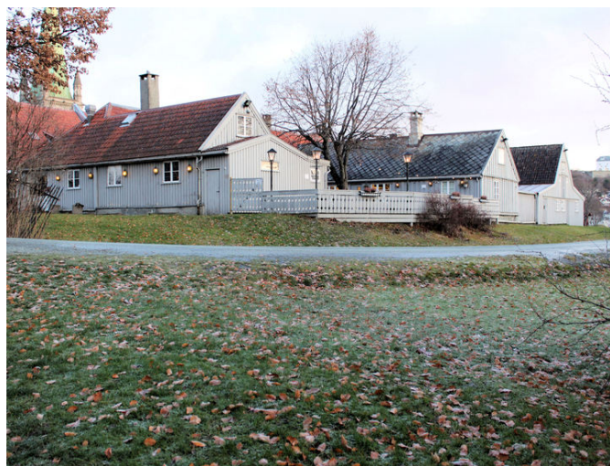
Sett fra sydvest. Det tidl. sprøytehuset y.t.h. Foto: J. Chr. Eldal, NIKU, 2014.
