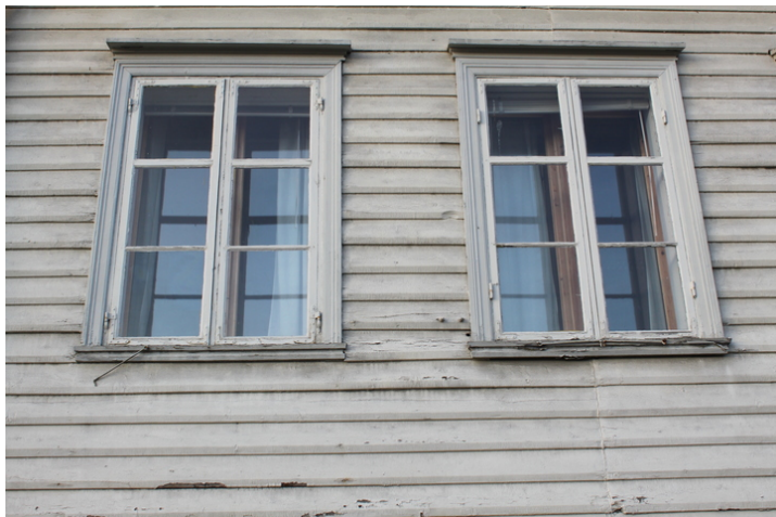
Østre langvegg med vinduene nr. 2 og 3 fra nord. Nr. 2 t.h. har yngre beslag og eldre fotos viser at vindusåpningen her er fra perioden ca. 1930-1947. Karakteristiske panelskjøter over og under dette vinduet. Foto: J. Chr. Eldal, NIKU, 2014. Opphavsrett: jce
