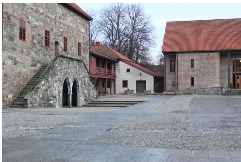
Borggården sett fra sydvest. Et lite mellombygg med gang forbinder eldre del t.v. med den nybygde Bispefløyen t.h. Foto: J. Chr. Eldal, NIKU, 2014. Opphavsrett: jce
