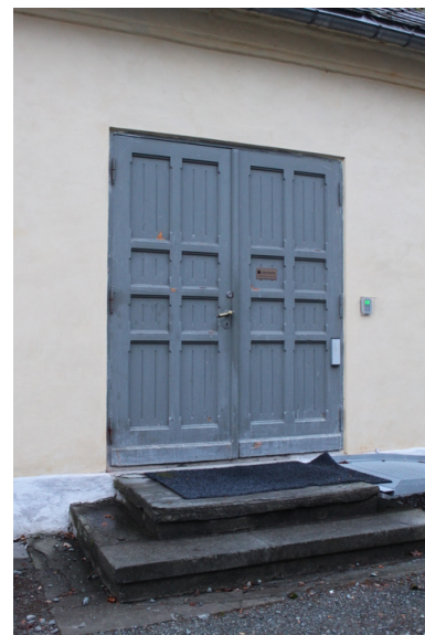
Hovedinngang sett fra nord. Foto: J. Chr. Eldal, NIKU, 2014. Opphavsrett: jce
