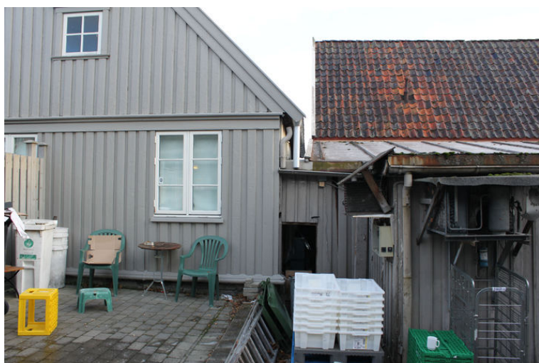
Vakthuset t.v. og det tidl. sprøytehuset t.h., sett fra vest. I forgr. t.h. et lite tilbygg fra ca 1965, bakenfor tilhører det blikketeke pulttaket det tidl. sprøytehuset mm. som ble flyttet hit fra borggården ca. 1870. Foto: J. Chr. Eldal, NIKU, 2014.
