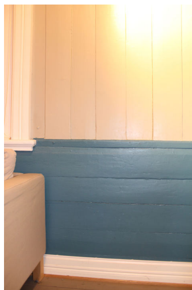
Veggpanel med markert brysting fra 1820-årene. Foto: J. Chr. Eldal, NIKU, 2014.
