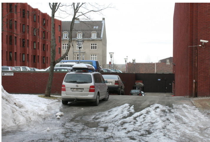
Sett fra syd. Parkeringsplassen på garasjetaket t.v. Foto: J. Chr. Eldal, NIKU 2009.
