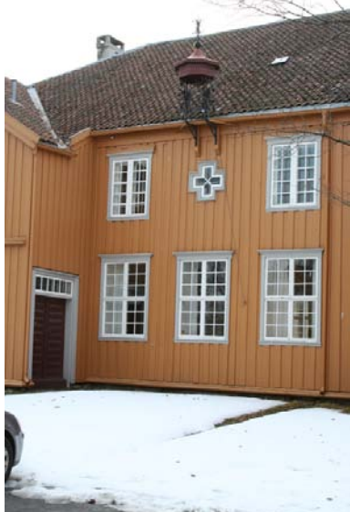
Gårdsfasaden med gammel fengselsdør og klokketårn, sett fra nordvest. Foto: J. Chr. Eldal, NIKU 2008.
