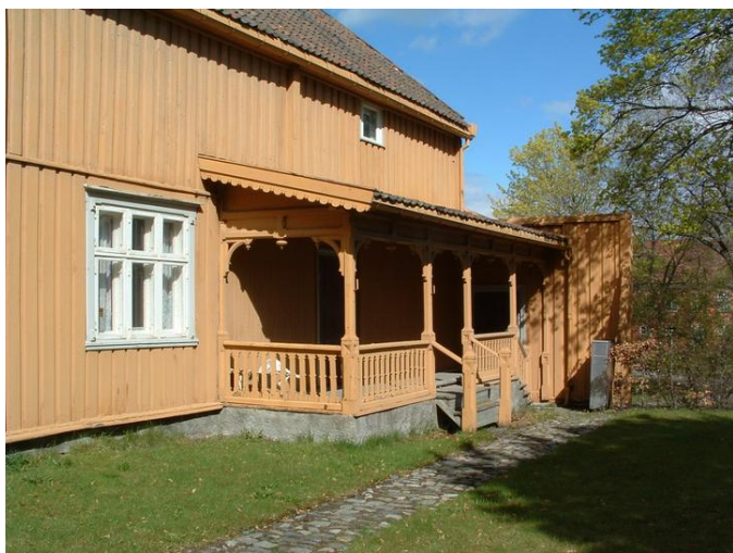
Østfløyen med direktørens veranda sett fra sydøst. Opphavsrett: Entra.
