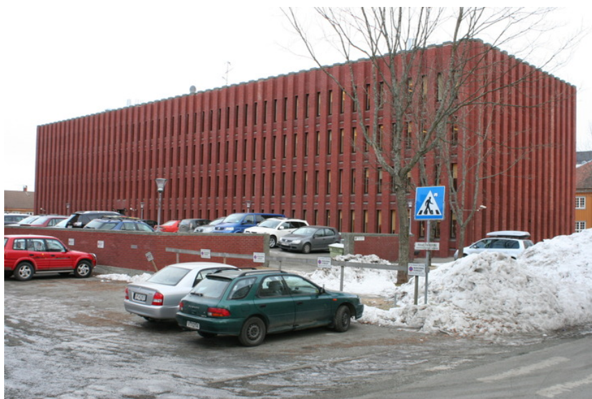
Sett fra sydvest med parkering på garasjetaket i mellomgrunnen t.v. Foto: J. Chr. Eldal, NIKU 2009.
