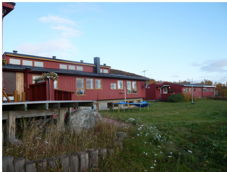
Hovedbygning nærmest og styrerbolig til høyre. Opphavsrett: Statsbygg.
