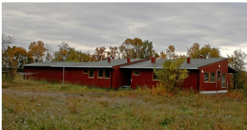
Betjeningsbolig med garasjetilbygg. Opphavsrett: Statsbygg.
