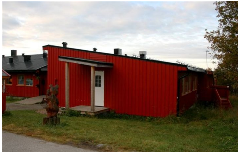
Inngang til soveromsfløy, nordøst. Foto: Ove Solsvik. Opphavsrett: BUFetat.
