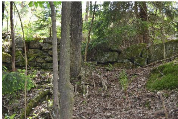
Kullhusene ligger i en bakke hvor de hestetrukne kullkorvene ble kjørt opp på baksiden og tømt ned i binger. Veien med snurampe på enden av kullhuset er intakt, delvis også murer og slaggsteinssøyler. Foto: KF 2016
