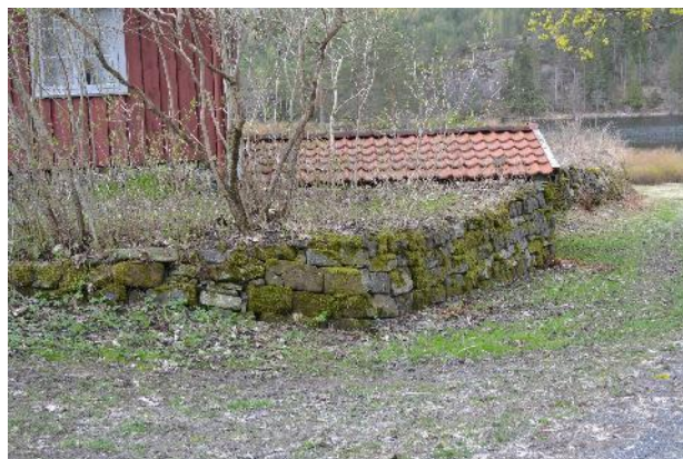
Den lange forstøtningsmuren ved Sletta er delvis bygd opp av fôringsstein som stadig ble skiftet ut fra masovnen ettersom de ble utbrent. Disse er nærmest trekantet i fasong og svakt buet, og muren ble derfor ikke alltid stabil. Foto: KF 2015
