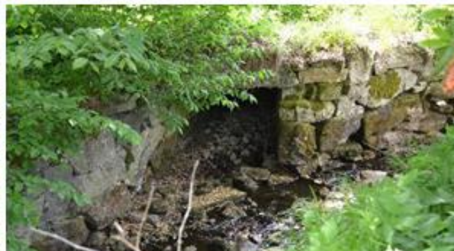
Svartelva har fra damstedet og ned til utløpet i Vadstøvannet natursteinsmurer på begge sider, oftest i en høyde av et par meter. Foto: KF 2015
