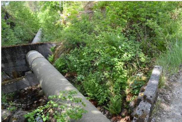
Dammen i Svartelva har stått i den smaleste kløften. Det fins bolter og merker etter festeanordning for dammen. Foto: KF 2016
