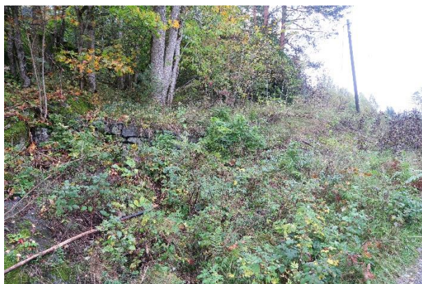
Forstøtningsmuren til bygningsflaten ses opp for veien. Foto NOS 2017.
