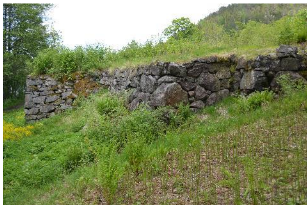
Forstøtningmur foran Rødgård og Skolen. Muren tjener også som hagemur for Rødgård, som var den eneste arbeiderboligen med hage og stakittverk. Foto KF 2016
