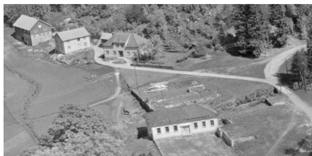
I 1860-åren ble det startet opp en stor produksjon av filer. Bygningen hvor denne virksomheten fant sted, ble kalt filefabrikken. Det var en lang bygning som lå på østsida av elven. I sliperiets tid ble bygningen brukt som tørkehus for tremassen. Tørkehuset brant i 1908, og ble deretter oppført i samme form, men i mur. På Widerøes flyfoto 1957 ser en murstrukturene bak kraftverksbygningen. Gjerstad Historielag
