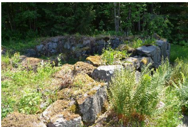
Nordre del av grunnmuren til skolen. Foto: KF 2016
