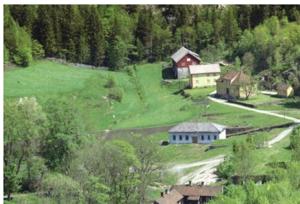
På flyfoto fra 1964 ser en tunet som ble bygd i Kroken like etter krigen. Her er et stort tradisjonelt uthus lagt bak bolighuset. I 1990-åra ble dette revet og et nytt uthus med nye funksjoner oppført på dets sted. Foto: Widerøes flyfoto. Gjerstad Historielag
