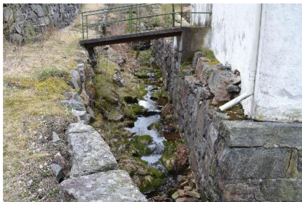
Kraftverkets plassering på elveforbygningene. Foto: KF 2015
