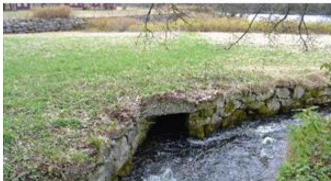
Svartelva har fra damstedet og ned til utløpet i Vadstøvannet natursteinsmurer på begge sider, oftest i en høyde av et par meter. Foto: KF 2015
