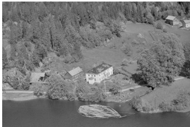
Flyfoto av den nye forvalterboligen 1958. Fjellanger Widerøe.
