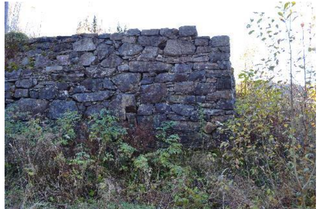
Stangjernhammeren var en stor og høy bygning med murt bakvegg mot sør og vest. Her var det storhammer og flere herder for oppvarming av jernet. Overvannshjulet lå ute i vestre renne i elva. Foto: KF 2015
