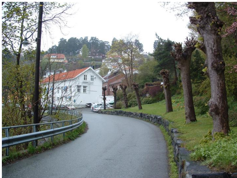
Kragerø politistasjon. Nord- og østfasade. Opphavsrett: Entra.
