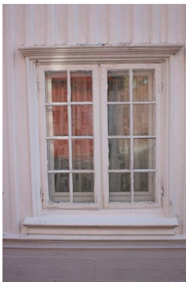
Originalt vindu på vestfasaden. Foto: Leidulf Mydland 2008. Opphavsrett: Entra.
