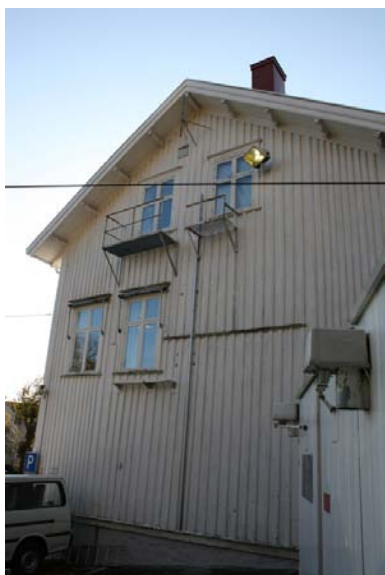
Bjørnsborg, nordre gavlvegg. Foto: Leidulf Mydland 2008. Opphavsrett: Entra.
