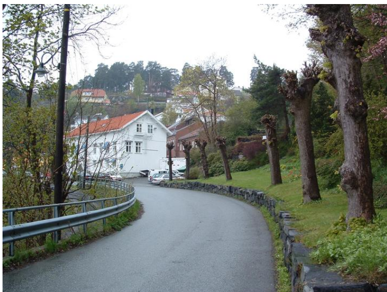
Kragerø politistasjon. Nord- og østfasade. Opphavsrett: Entra.
