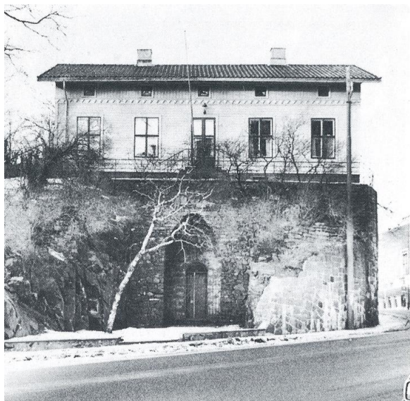
Wergelandsv. 4 etter veitvidelsen. Inngang til grotten under huset er murt inn i fjellet. Opphavsrett: Statsbygg.
