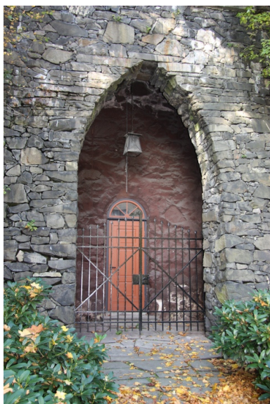
Inngangen til Grotten Opphavsrett: Statsbygg
