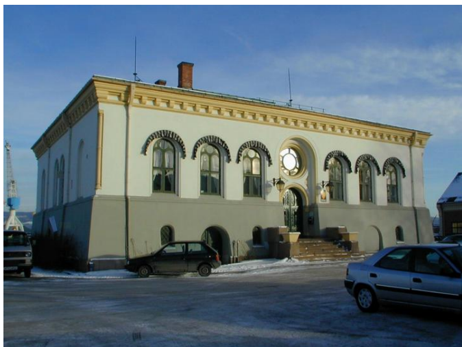
Vestfasaden med hovedinngangen. Opphavsrett: Entra.
