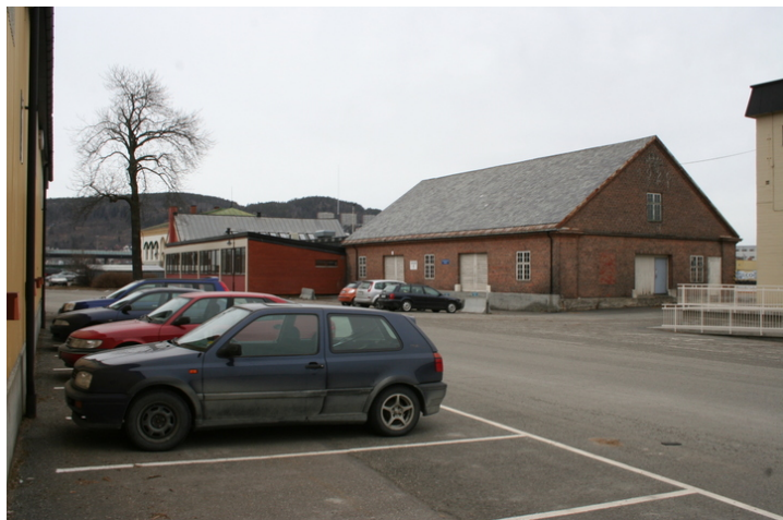
Sett fra syd med pakkhuset fra 1957 t.h. Midt i bildet det kommunale havnelageret som ble oppført på Tollvesenets tomt i 1927. Foto: J. Chr. Eldal, NIKU 2008.
