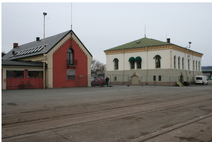
Sett fra øst med pakkhus og veierbod t.v. Foto: J. Chr. Eldal, NIKU 2008.
