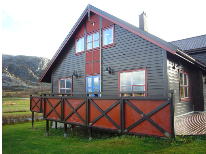
Veranda. Opphavsrett: Statsbygg.
