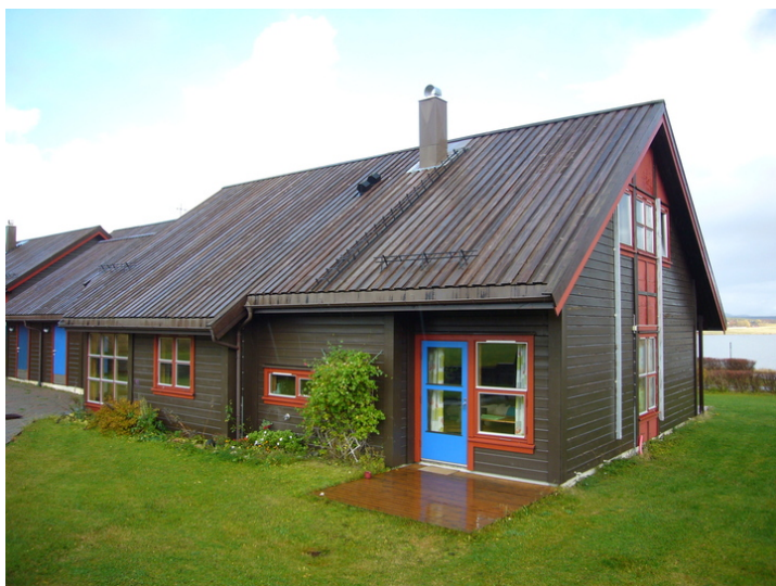
Bolig 2. Fasadene mot sørvest og sørøst Opphavsrett: Statsbygg.
