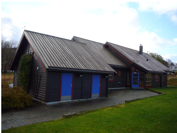
Bolig 1, fasader øst og nord. Opphavsrett: Statsbygg.
