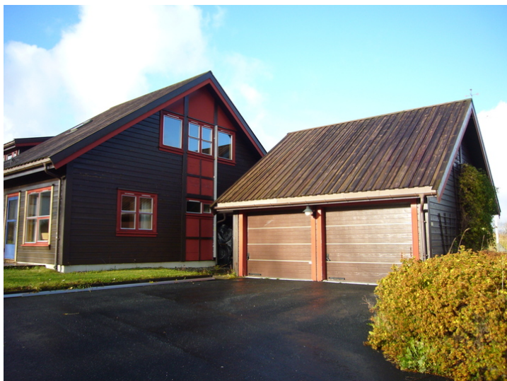
Bolig 1, garasjen sett fra syd. Opphavsrett: Statsbygg.
