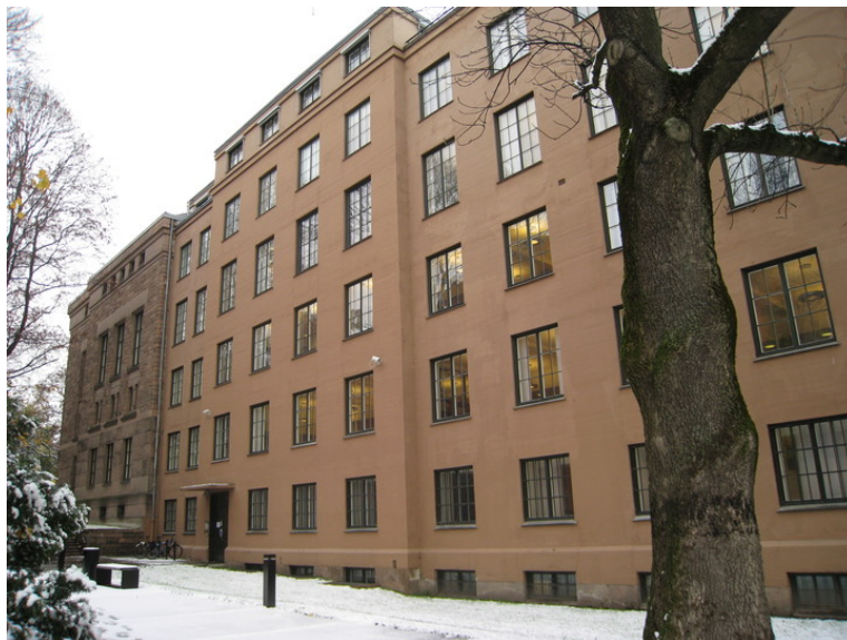
Fasade vestfløyen med fasade fra 1933. Foto: Foto L.J. Hvinden-Haug, NIKU 2008.
