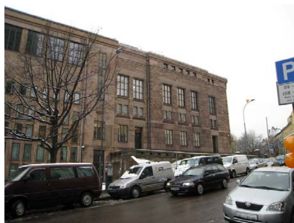
Østfasaden fra 1914 med del av magasinfasaden fra 1945 t.v.. Foto: Foto L.J. Hvinden-Haug, NIKU 2008.
