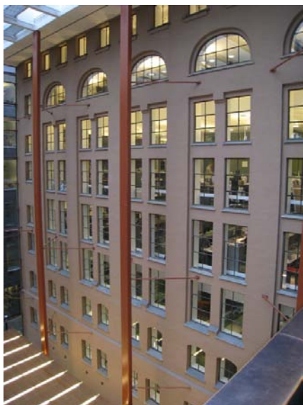
Tidligere utvendig fasade mot øst på vestre magasinfløy fra 1908, innbygget i lysgård fra 2003. Foto: Foto L.J. Hvinden-Haug, NIKU 2008.
