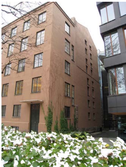
Magasinfløy fra 1914 med tilbygning fra 1933 i forgr. t.v. Foto: Foto L.J. Hvinden-Haug, NIKU 2008.
