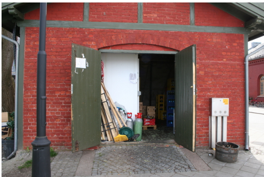
Nordre gavlvegg. Den hvite vegg tilhører kjølerommet som er oppført som frittstående inne i halvdel av det tidligere båthuset. Foto: J. Chr. Eldal, NIKU 2008.
