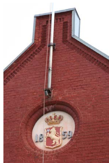
Riksvåpen i gavlen mot kanalen. Foto: J. Chr. Eldal, NIKU 2008.
