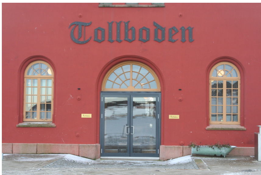
Alle vinduene er nye kopier. To gamle pakkhusporter står oppslått inn i restauranten og med nye glassdører monterert i åpningene som her i nordveggen. Foto: J. Chr. Eldal, NIKU 2008.
