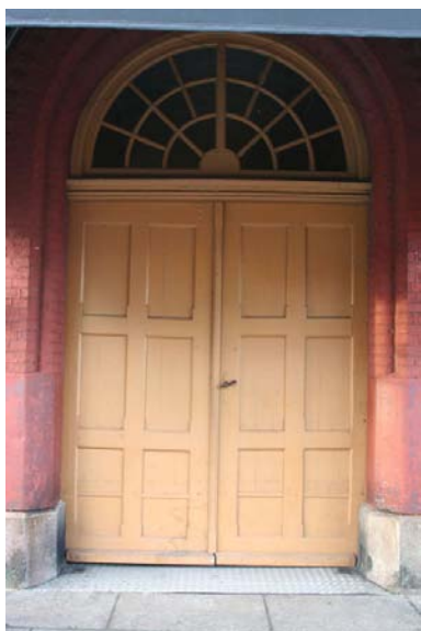
Hovedinngangen midt på østre langvegg til restaurantens vestibyle er en opprinnelig pakkhusport. Foto: J. Chr. Eldal, NIKU 2008.
