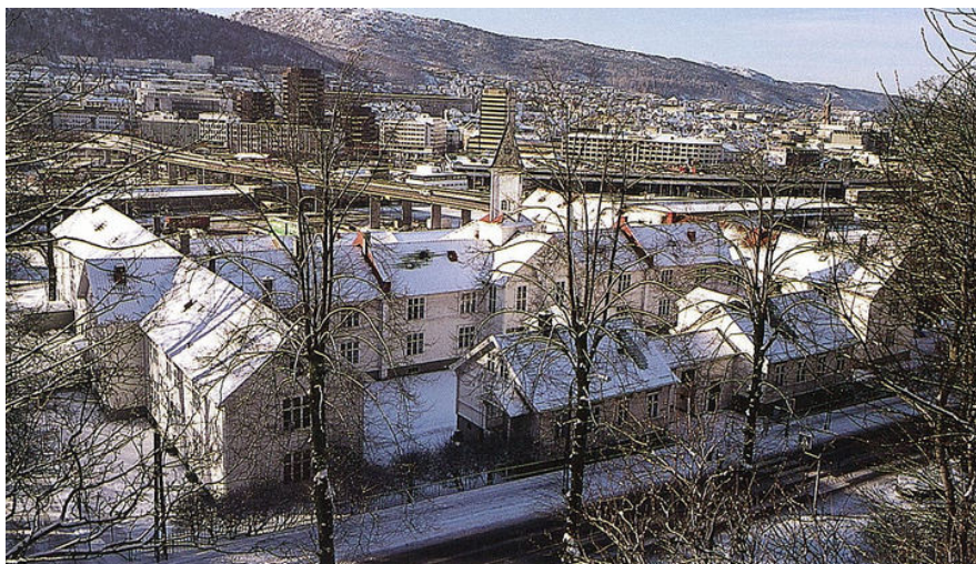
Anlegget sett fra nordøst. Opphavsrett: Statsbygg ferdigmelding 573/1999.
