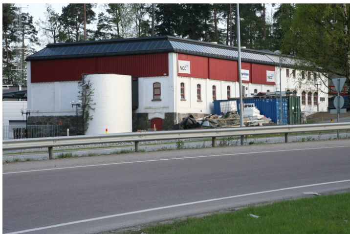
Eldste del av läven ble oppført i nytt uttun ca 1860. Den er nå adskilt fra det øvrige gamle gårdsanlegget av de store nybyggene fra 1980-årene og dessuten sterkt ombygget. Läven foreslås ikke fredet, men er regulert til bevaring. Foto: J. Chr. Eldal, NIKU 2009.
