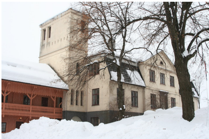
Tårnet ble oppført som brannskille og tjenestetrapp. Det knyttet spisestuen i hovedbygningen til et nytt kjøkken i østfløyens 2. etasje og ga rom for en liten utsiktssalong på toppen. Foto: J. Chr. Eldal, NIKU 2009.
