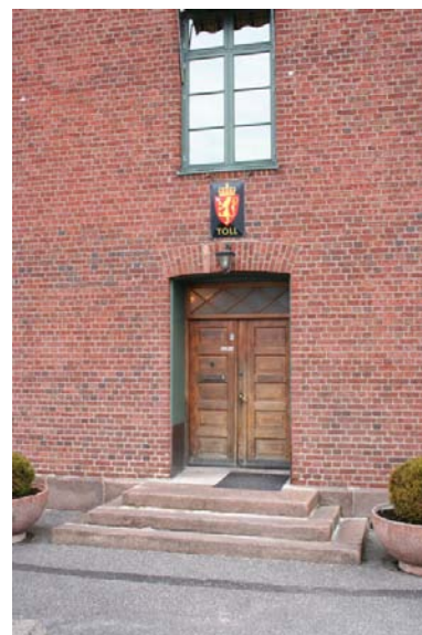
Sydfasaden med hovedinngang. Nyere dør, kanskje i oppr. utforming. Foto: J. Chr. Eldal, NIKU 2008.
