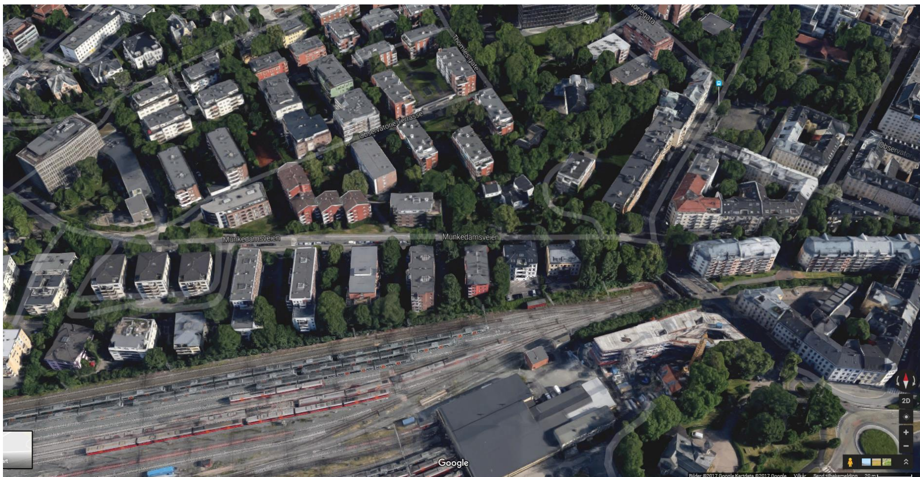
Situasjonsoversikt over Munkedamsveien med nærliggende områder. Vi ser at området i dag er tett utbygd, bebyggelsen består hovedsakelig av blokker og bygårder. Skjermbilde fra Google maps 2017.
