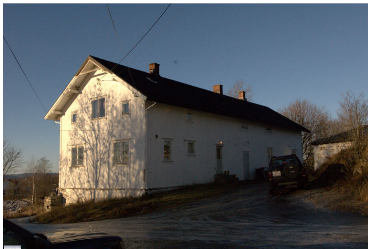
Sidebygningen. Potetkjeller til høyre. Foto: C.Borhaven, Forsvarsbygg.
