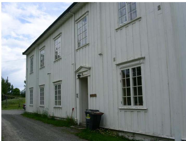
Nordfasade med inngang Foto: Poul Neubert
