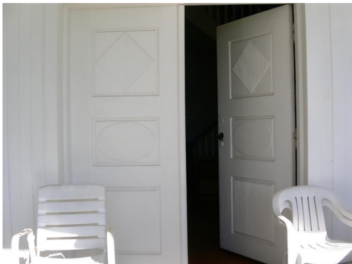
Inngangsdør til hall, fra hagesiden Foto: Poul Neubert
