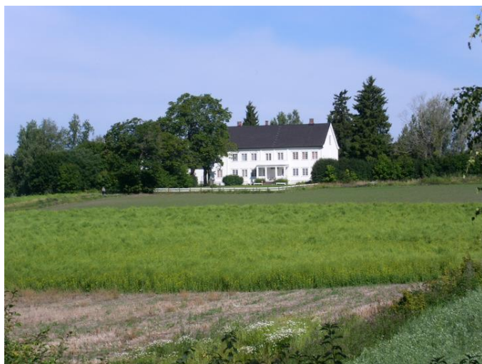
Hovedbygning sett fra syd. Foto: Poul Neubert Opphavsrett: Forsvarsbygg.
