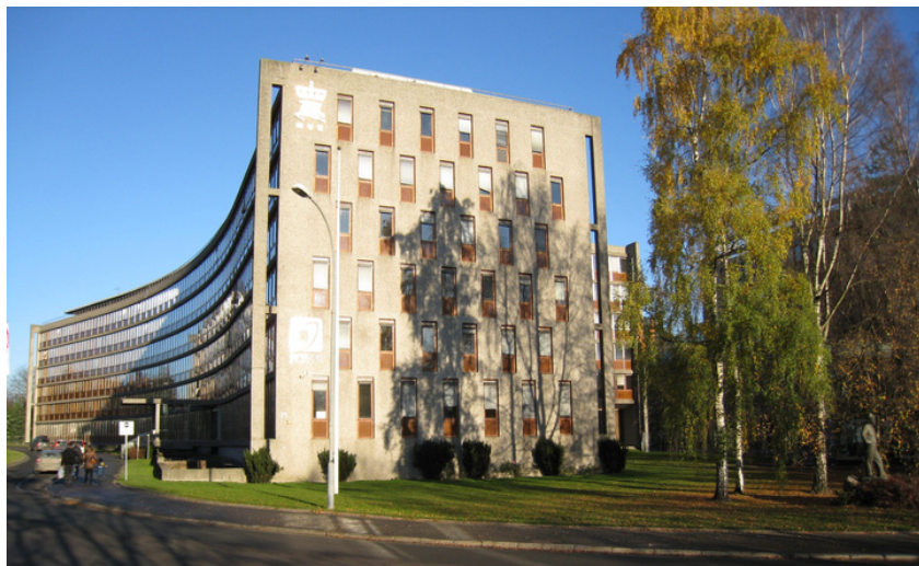
Sør- og vestfasadene mot Middelthunsgate Foto: NIKU v/Anne Sætren 2008
