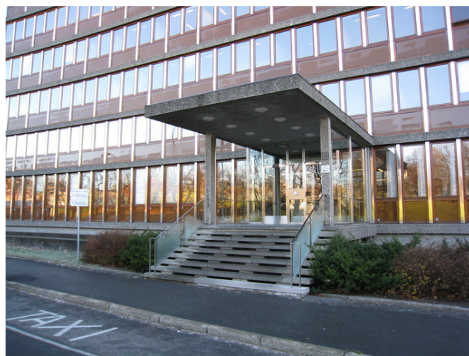
Hovedinngangen med bru med baldakin over vannbasseng. Foto: NIKU v/Anne Sætren 2008.
