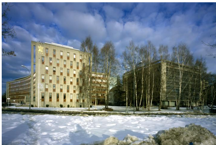
NVE- og NHO-byggene. Opphavsrett: Entra.
