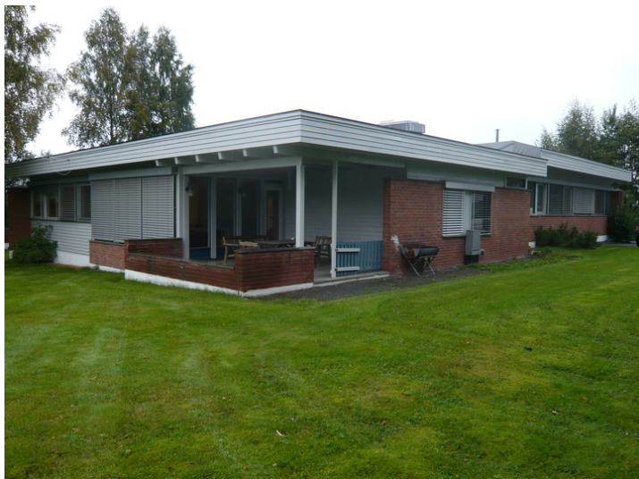
Terrasse mot vest. Til høyre for terrassen lå opprinnelig bestyrerinnerrommet med sovenisje, mens felles stue lå til venstre. Opphavsrett: Statsbygg.
