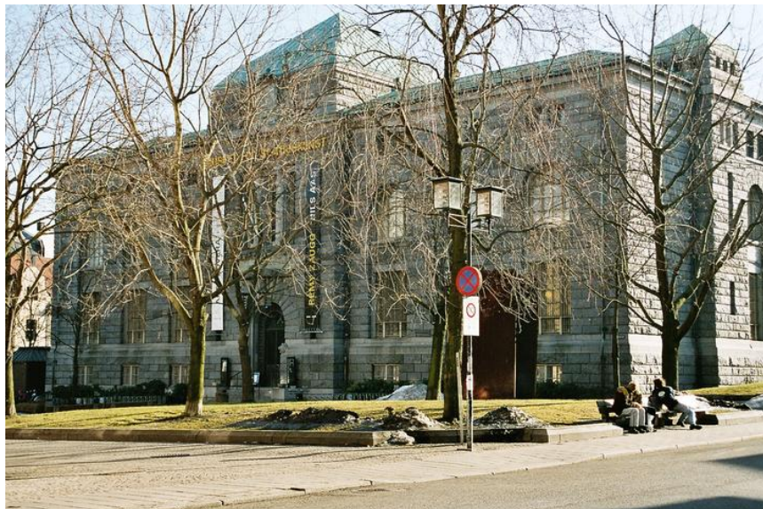
Nord- og vestfasade. Foto: Marianne Gulliksen. Opphavsrett: Statsbygg.
