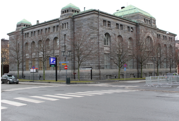
Vest- og sydfasade. Nedkjøring til underjordisk parkeringsanlegg ved hjørnet i forgrunnen. Foto: J. Chr. Eldal, NIKU 2012.
