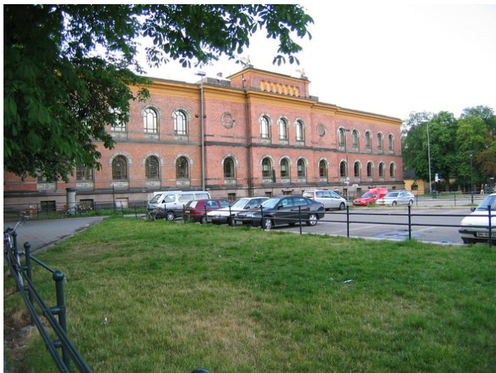
Bildet viser Nasjonalgalleriets Vestfasade mot Tullinløkka Foto: Erik Ruud Opphavsrett: statsbygg
