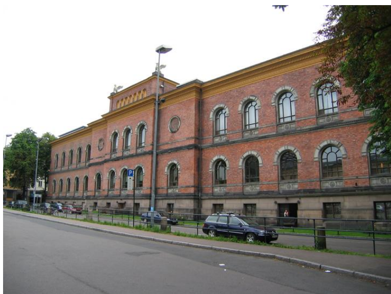
Bildet viser Nasjonalgalleriets vestfasade mot Tullinløkka Foto: Magnus Torp Opphavsrett: Statsbygg
