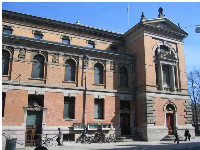
Fasade langs Stortingsgaten med personalinngang i underetasjen. Foto: NIKU 2008.
