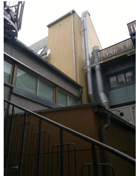
Gårdsrommet er fylt av nyere tilbygg og tekniske anlegg. Opphavsrett: Statsbygg.
