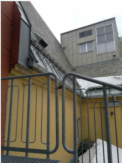
Gårdsrom. Del av gjenværende fasade over nyere tilbygg og tekniske anlegg. Opphavsrett: Statsbygg.
