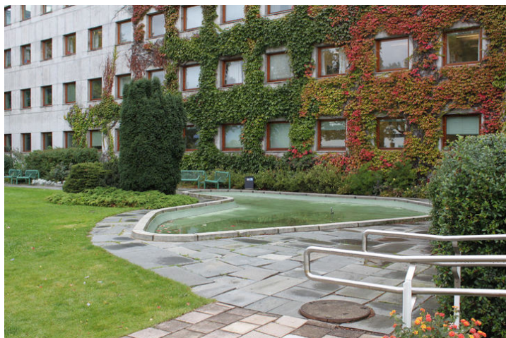
Hageanlegg foran frontfløyen med bassenget i hjørnet ved A-fløyen. Foto: J. Chr. Eldal, NIKU, 2012.
