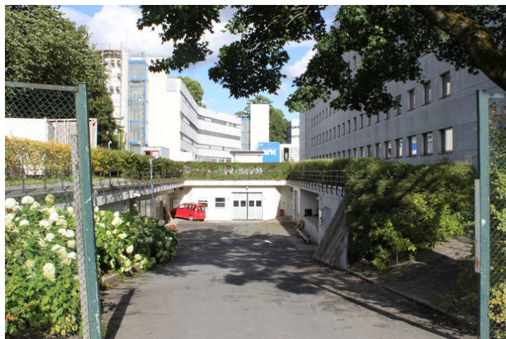
Innkjøringsbrønn til underjordisk p-anlegg vest for B-fløyen. Sett fra syd. Foto: J. Chr. Eldal, NIKU, 2012.
