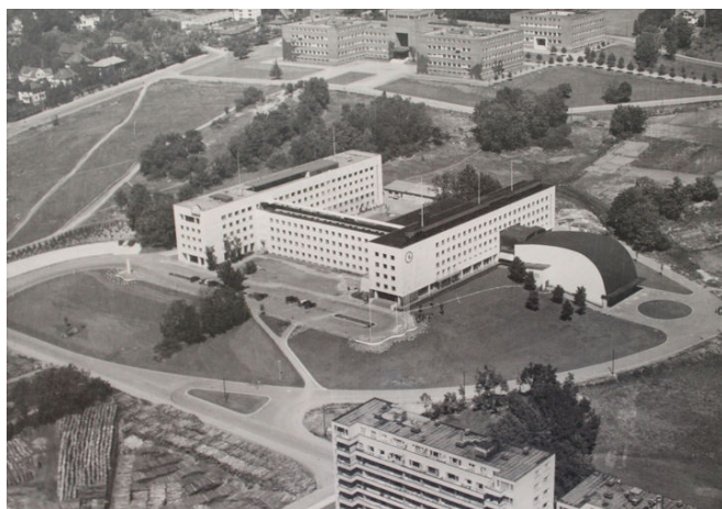
Kringkastingshuset slik det ble fullført under og etter 2. verdenskrig. Sett fra sydøst. Foto: Widerøe Flyveselskap 1949. Opphavsrett: NRK.
