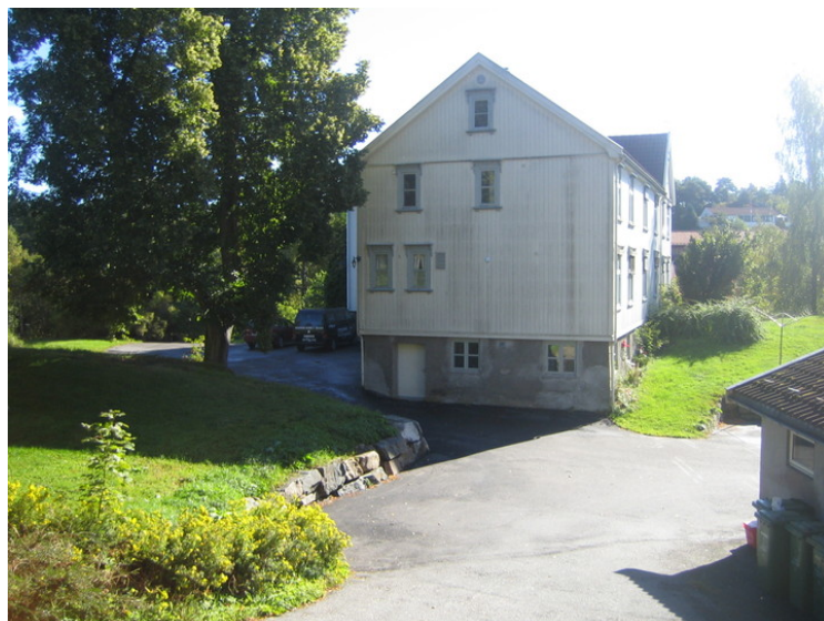
Soveromsfløyen mot vest. Opphavsrett: Statsbygg.
