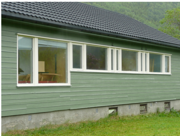
Bolig 2. Detalj av fasade mot sør. Ophavsrett: Statsbygg.
