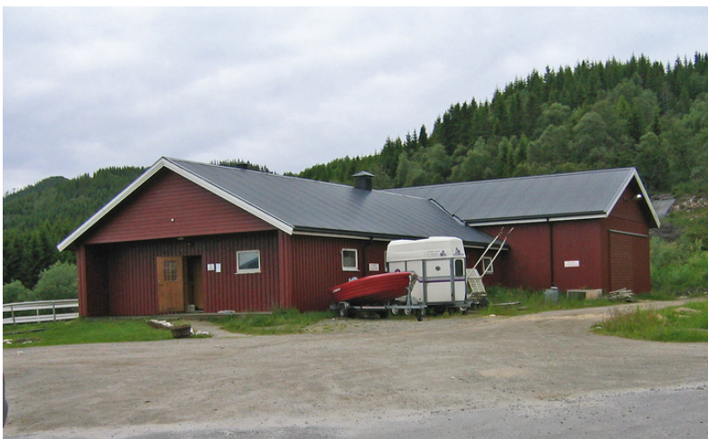
Stallen sett fra internveien. Ophavsrett: Statsbygg.
