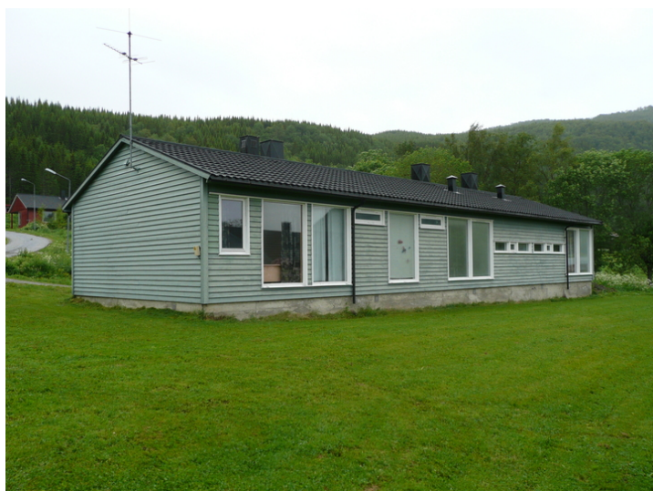
Hybelbygg sørfasade. Opphavsrett: Statsbygg.
