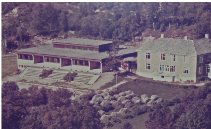
Skolefløyen fra ca 1970 hadde tribuner mot skoleplass, og nisjer i fasaden som uværsskur. Opphavsrett: Statsbygg.
