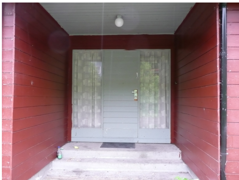
Inngangspartiet venter mot nord. Opphavsrett: Statsbygg.
