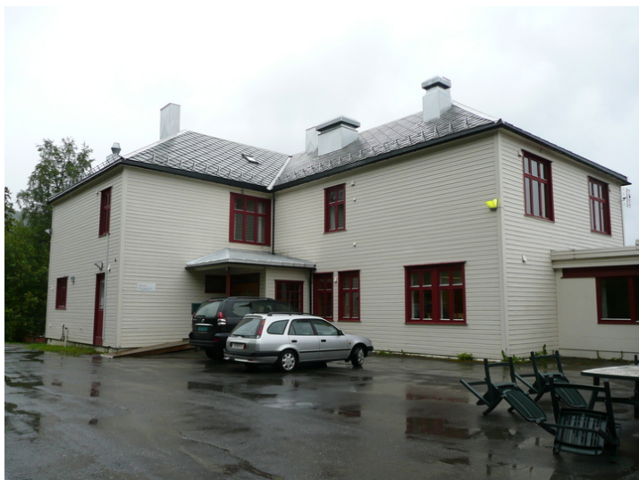
Inngang hovedbygg. Opphavsrett: Statsbygg.
