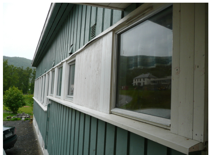
Vindusbånd er karakteristisk for disse paviljongene fra 1960-tallet. Opphavsrett: Statsbygg.
