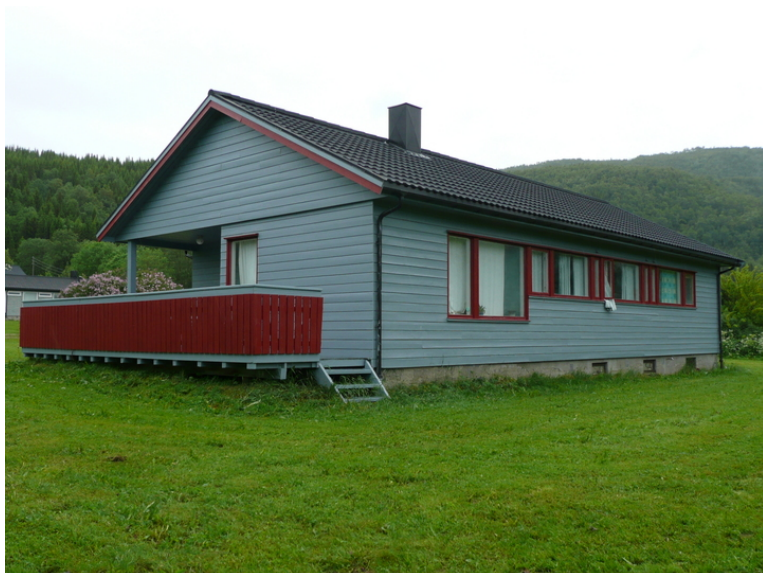
Bolig 3 sett fra sørvest. Opphavsrett: Statsbygg.
