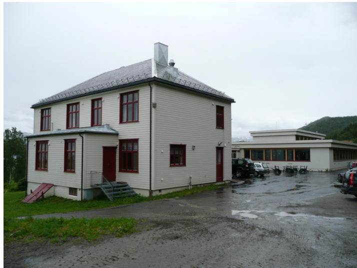
Administrasjons- og skolebygget sett fra nordøst. Opphavsrett: Statsbygg.
