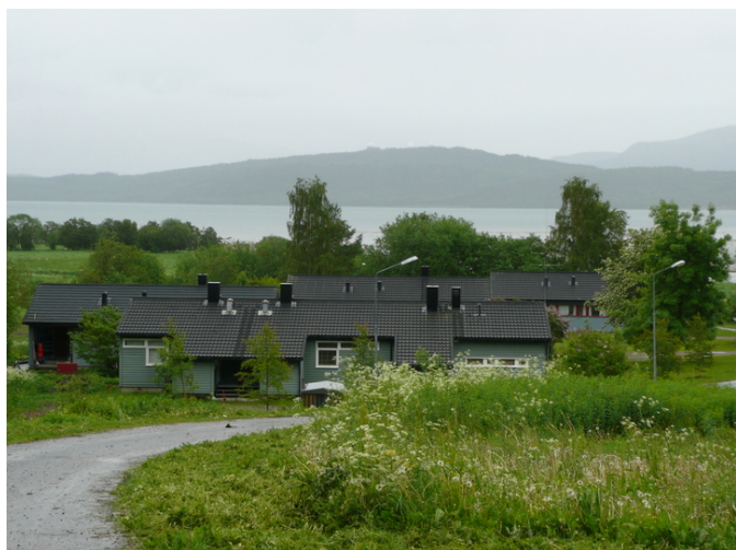
Utsyn fra eiendommen mot fjorden. Hybelbygg i front, personalbolig 1-3 bakenfor. Opphavsrett: Statsbygg.
