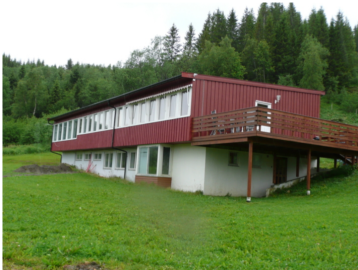
Åsheim familieavdeling. Hybelleilighet i kjelleren med karnapp. Opphavsrett: Statsbygg.
