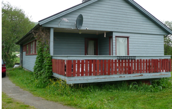
Bolig 1 sett fra vest. Opphavsrett: Statsbygg.
