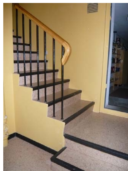
Detalj trapp Opphavsrett: Statsbygg
