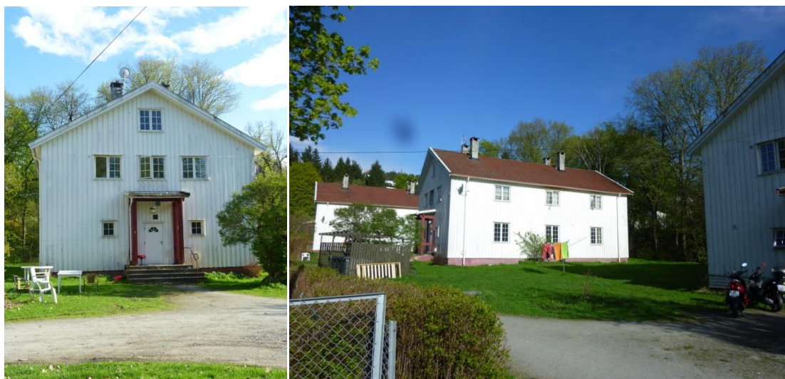
Foto: Byantikvaren i Oslo, april 2012
