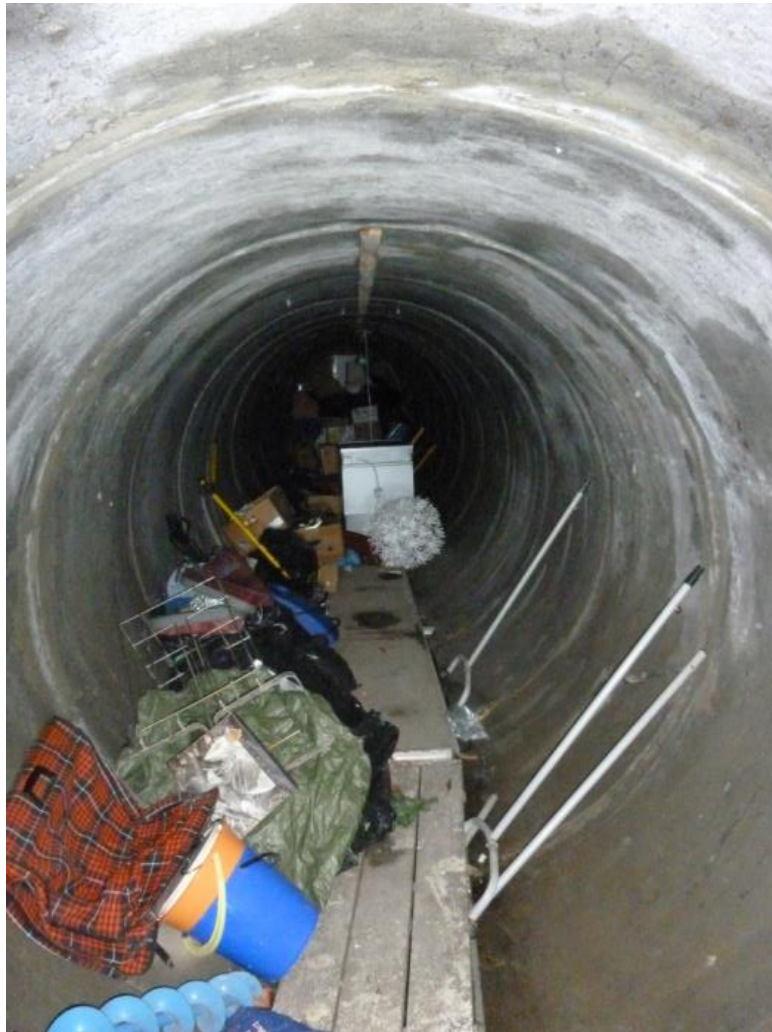
Bunkere. Foto: Byantikvaren i Oslo, oktober 2012.
