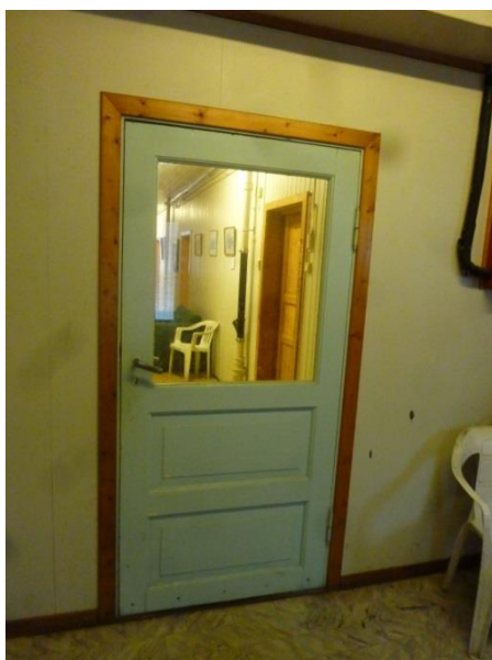
Dør til korridor 1.etg. Foto: Byantikvaren i Oslo, januar 2014.
