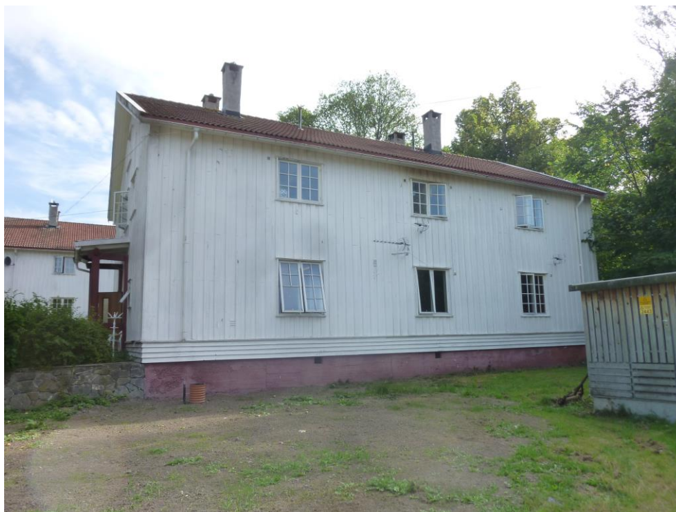
Kasernebygg B/4. Foto: Byantikvaren i Oslo, september 2013.
