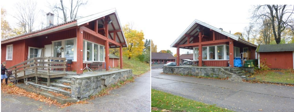
Foto: Byantikvaren i Oslo, oktober 2012
