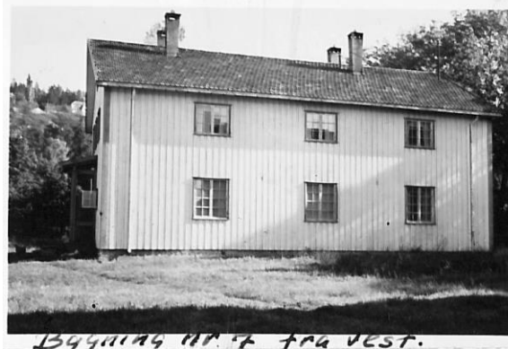
Bygning nr. 7 fra vest.
