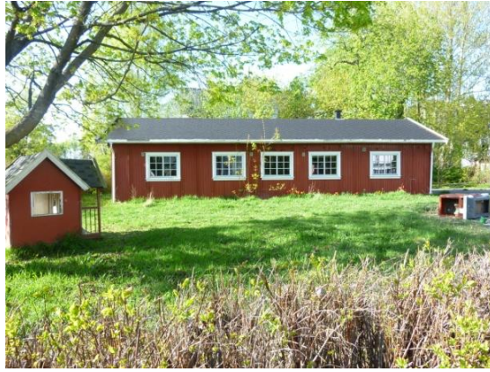
Foto: Byantikvaren i Oslo, oktober 2012.
