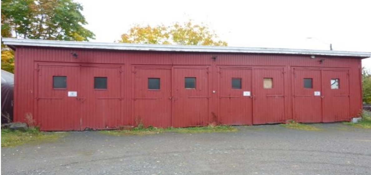
Foto: Byantikvaren i Oslo, oktober 2012.
