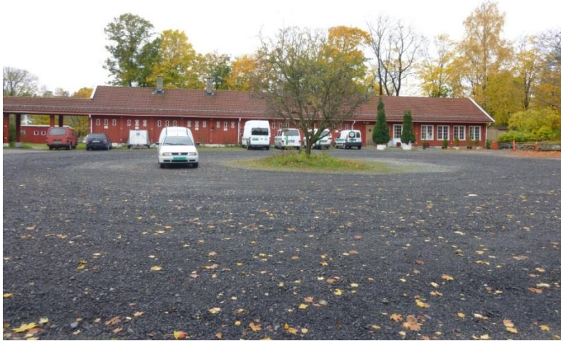
Nedre terrengnivå med gårds/paradeplass. Foto: september 2013, Byantikvaren i Oslo.
