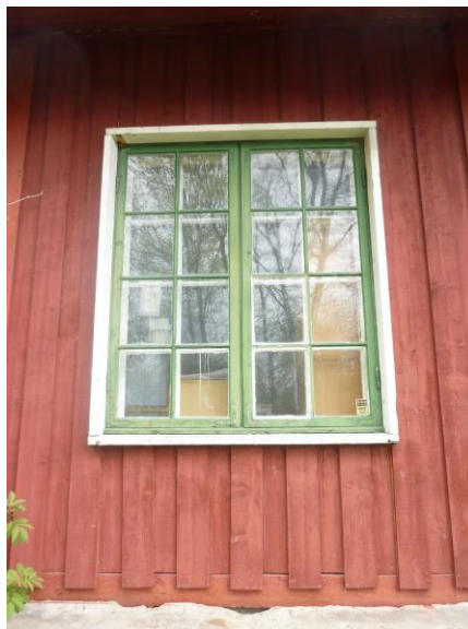
Vindu vinkelbygg nord. Foto: Byantikvaren i Oslo, sept. 2013.
