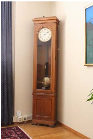
4. et. Tolldirektørens kontor. Det sentrale ur som oppr. drev alle ur i huset via elektrisk overføring. Foto: J. Chr. Eldal, NIKU 2008.
