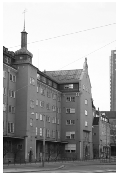
Trappehusene langs Schweigaardsgate. Hovedtrapp i midten, personaltrapp t.h. Foto: J. Chr. Eldal, NIKU 2008.
