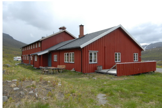
Fasade NV. Foto: M. Oftedal, Forsvarsbygg.
