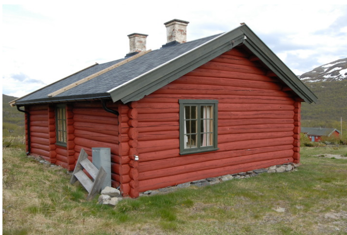
Fasade V. Foto: M. Oftedal, Forsvarsbygg.
