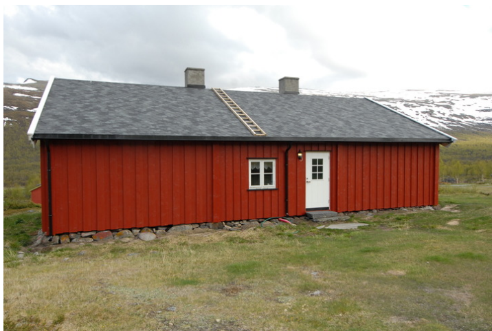
Fasade nord, inngangsparti. Foto: M. Oftedal, Forsvarsbygg.
