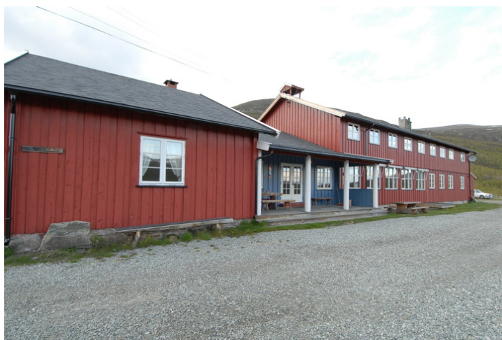
Hovedbygningen, fasade sør. Foto: M. Oftedal, Forsvarsbygg.
