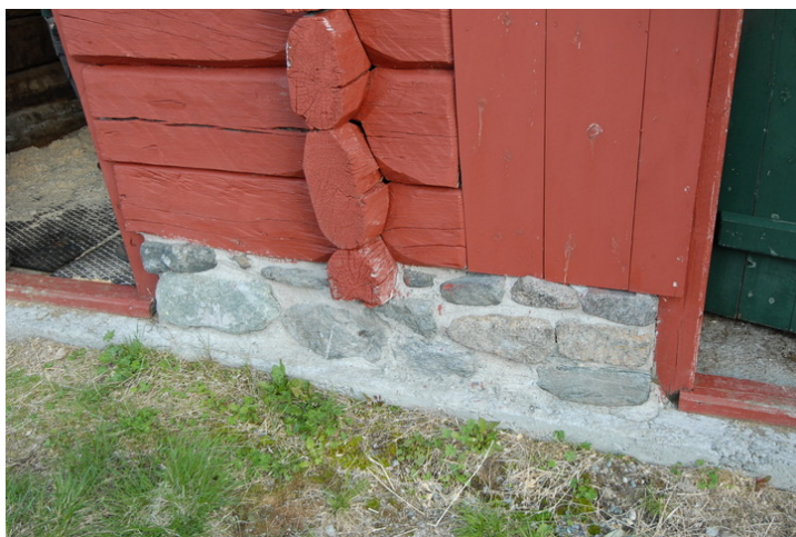
Detalj yttervegg, ny mur. Foto: M. Oftedal, Forsvarsbygg.
