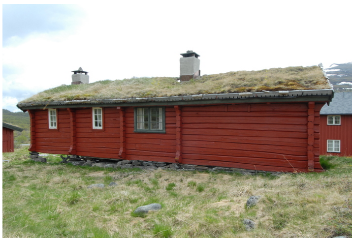
Fasade nordsiden. Foto: M. Oftedal, Forsvarsbygg.
