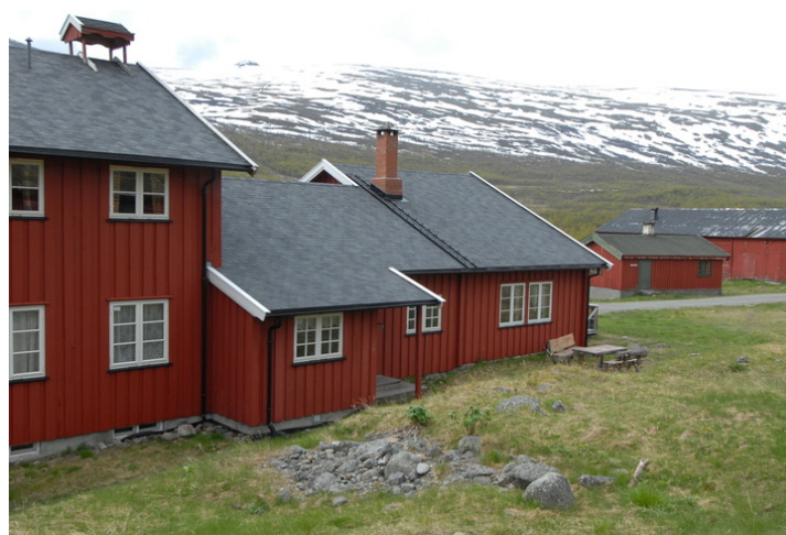
Fasade nordsiden. Foto: M. Oftedal, Forsvarsbygg.
