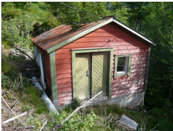
Kraftstasjonen. Opphavsrett: Statsbygg.
