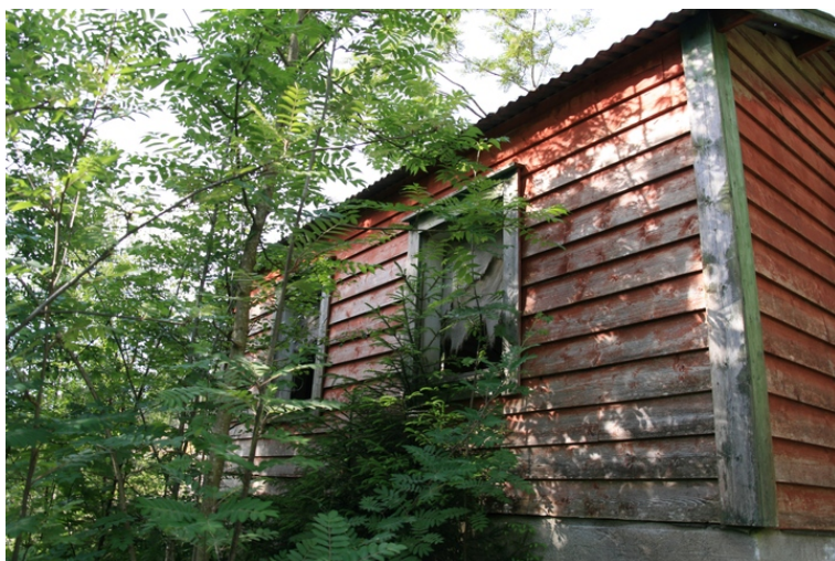
Kraftstasjonen. Opphavsrett: Statsbygg.
