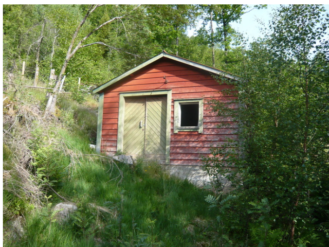
Kraftstasjonen. Opphavsrett: Statsbygg.
