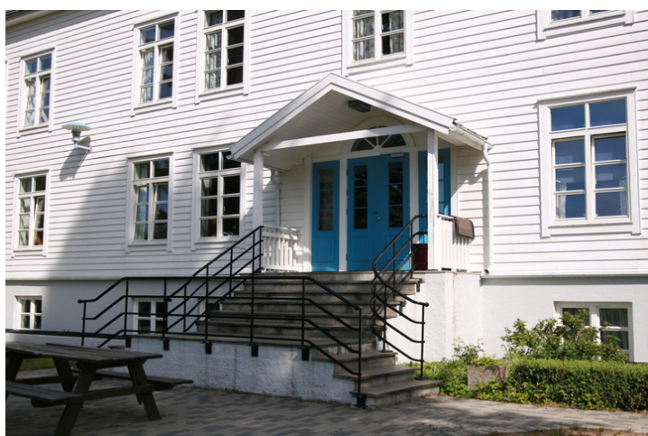
Inngang fra hagen. Opphavsrett: Statsbygg.
