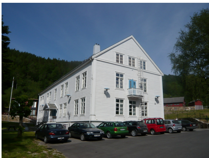
Fasader mot syd og øst. Opphavsrett: Statsbygg
