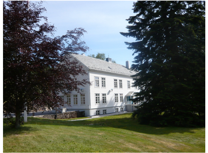
Hovedbygning sørvest. Opphavsrett: Statsbygg.
