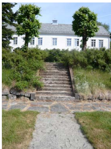
Trapp fra hage til hovedbygning. Opphavsrett: Statsbygg.
