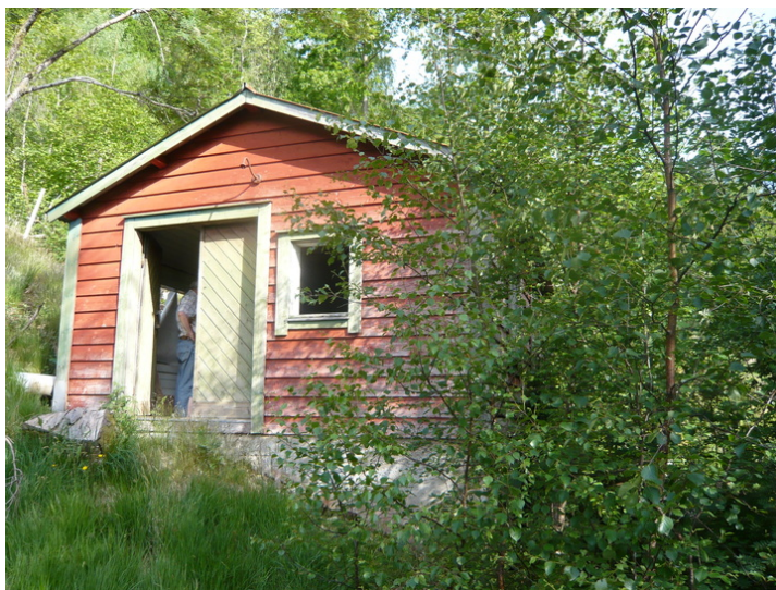
Kraftstasjonen. Opphavsrett: Statsbygg.
