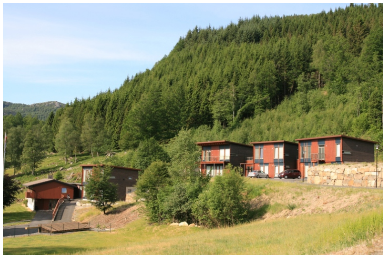
Boligpaviljonger. Opphavsrett: Statsbygg.
