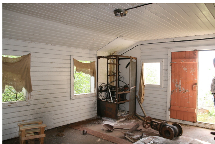
Kraftstasjonen innvendig. Opphavsrett: Statsbygg.
