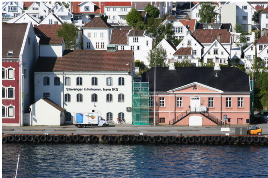
Den tidligere tollboden fra 1840 på Strandkaien, med pakkehuset som ble påbygget en etasje etter at Tollvesenet flyttet ut. Foto: J. Chr. Eldal, NIKU 2008.
