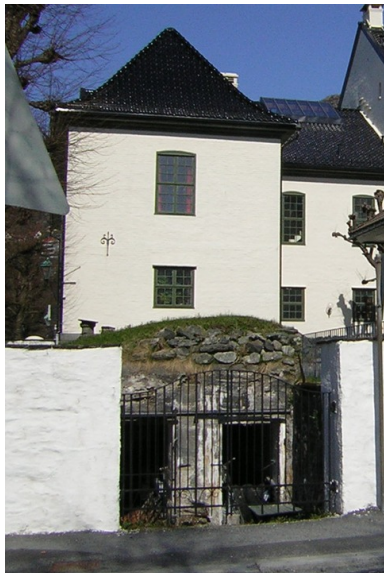
Nedgangen til garasjen er i porten i muren Foto: Siv Nytrøen Leden © Riksantikvaren 2005
