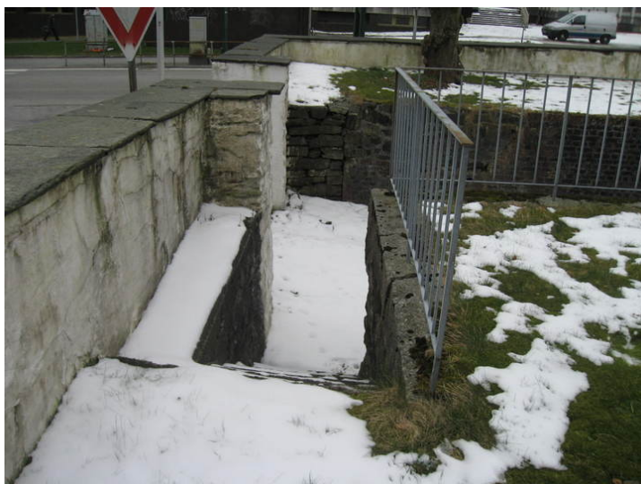
Trapp fra øst og ned til innkjøringen til garasjen. Foto: Gunnar Birkeland NIKU 2008
