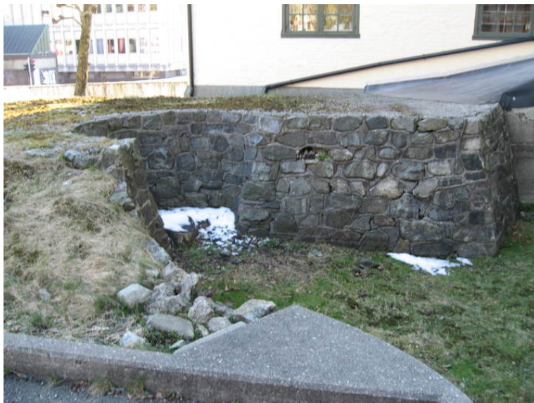
Bunkersoverdekking Foto: Gunnar Birkeland NIKU 2008
