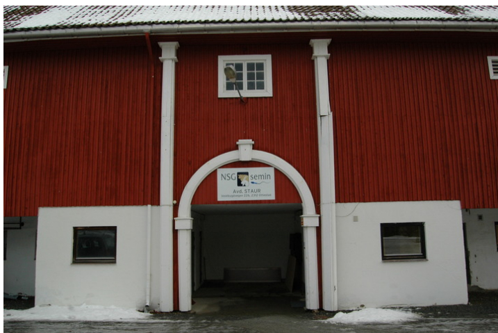
Opprinnelig gjennomkjøring, sentralt på vestfasaden. Foto: M. Oftedal, Forsvarsbygg.
