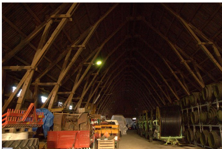
Foto: C.Borhaven, Forsvarsbygg.
