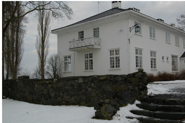
Fasade mot sør. Foto: M. Oftedal, Forsvarsbygg.
