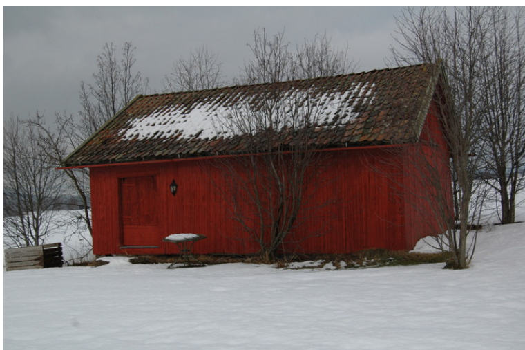
Uthuset. Foto: M. Oftedal, Forsvarsbygg.
