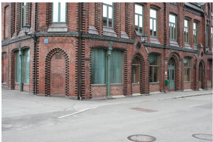
Gatefasadene har flere gjenmuringer i dør- og vindusåpninger som ikke er opprinnelige. Hoveddøren t.h. er en kopi fra 1999.
