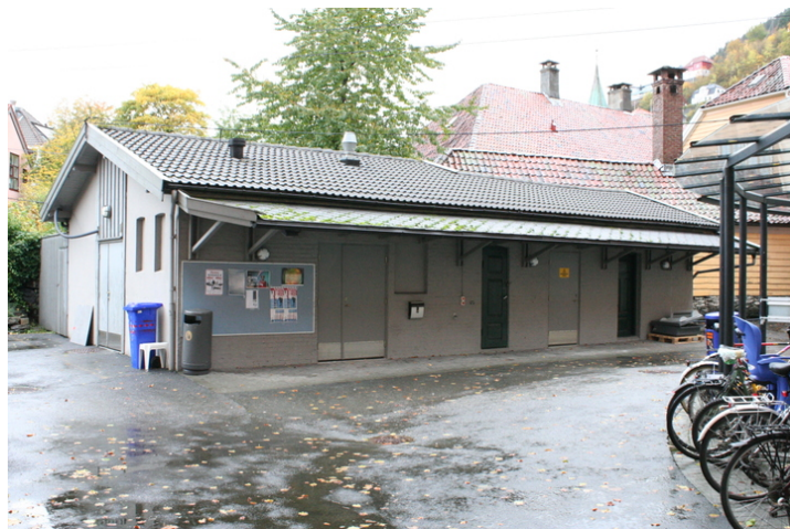
Uthus ved gårdsplassen sett fra syd. Foreslås fredet. Foto: J. Chr. Eldal, NIKU 2008.
