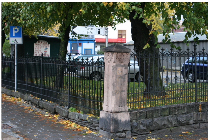
Gjerdet rundt sydvestre del av eiendommen har granittstolper og jernstakitt preget av nygotikk som kan være like gammelt som skolebygningen. Foto: J. Chr. Eldal, NIKU 2008.
