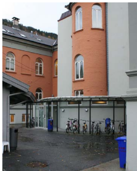
Trappehuset på gårdsiden med inngangsparti og sjakter for heis og toaletter fra 1990-årene. Foto: J. Chr. Eldal, NIKU 2008.
