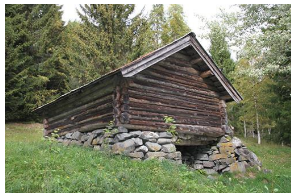
Figur 10. Fasade mot sør.
