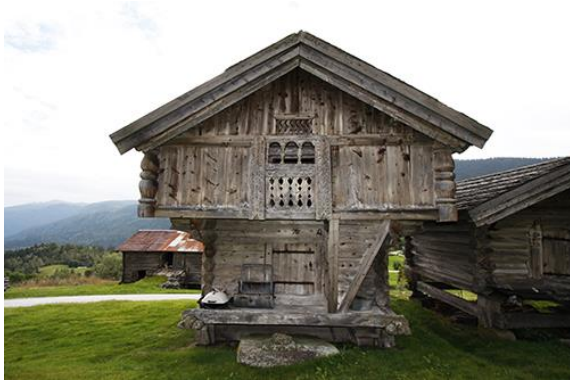
Figur 4. Fasade mot nord-vest
