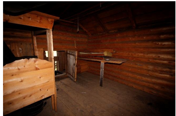
Figur 24. Nordre hjørne av loftsrommet
