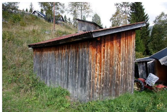
Figur 63. Vedskjul, med saga og ny bolig i bakgrunnen.
