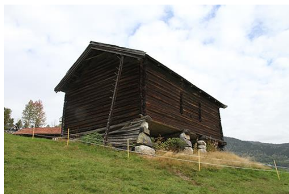
Figur 18. Fasade mot sør
