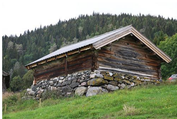
Figur 20. Fasade mot øst
