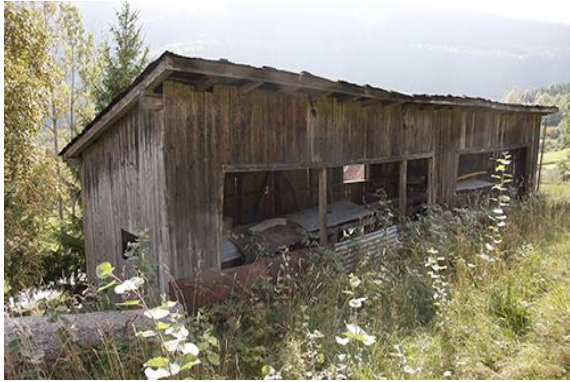
Figur 21. Fasade mot nord
