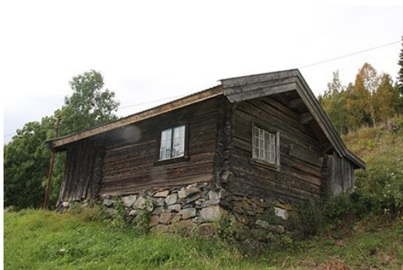
Figur 15. Fasade mot øst
