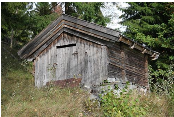
Figur 13. Fasade mot sør
