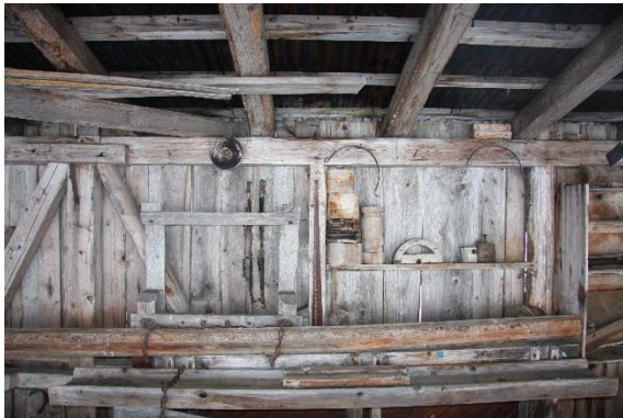
Figur 56. Vegg mot sør-øst, med oppbevaring av ruller og drivhjul
