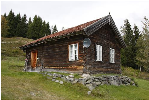
Figur 11. Fasaden mot sør
