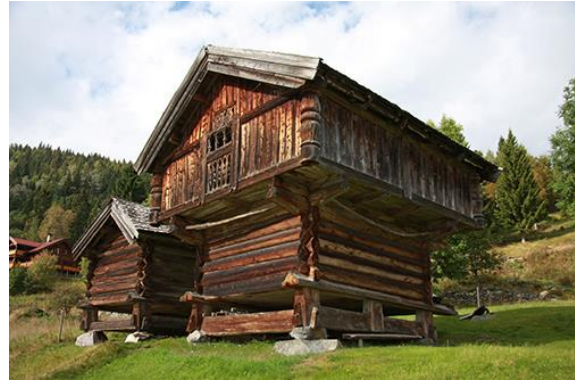
Figur 5. Fasade mot øst
