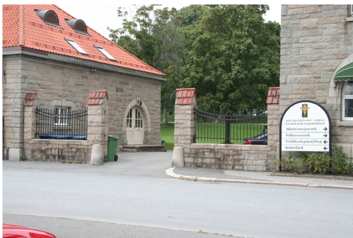
Gjerdet mellom bygningene sett fra sydøst. Foto: J. Chr. Eldal, NIKU 2006.
