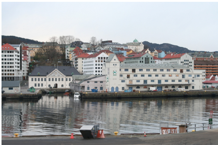
Sett fra nordøst med havnelageret fra 1923 t.h. Foto: J. Chr. Eldal, NIKU 2008.
