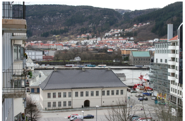
Sett fra sydvest med Bergenhus og Håkonshallen i bakgr. Foto: J. Chr. Eldal, NIKU 2008.
