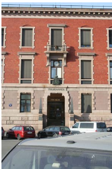
Hovedinngangen sett fra sydøst.
