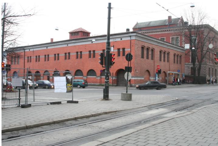
Sett fra nord. Fasaden t.h. ble oppført da bygningen ble forkortet med 8 m i 1956.
