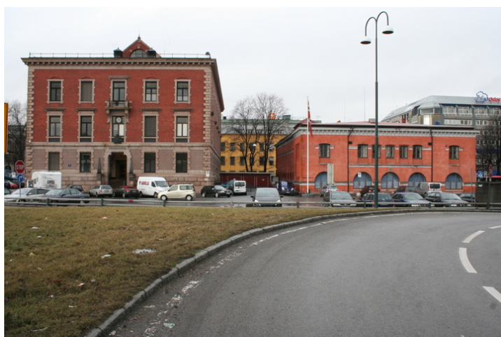
Oslo sjøtollsted sett fra øst. Foto: J. Chr. Eldal, NIKU 2008.
