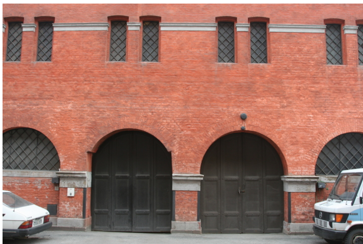
Oppr. pakkhusport av jern t.h. og kopi utført i tre 2004 t.v. Forhugning i murverket for tidligere vippeport. Sett fra sydvest. Foto: J. Chr. Eldal, NIKU 2008.
