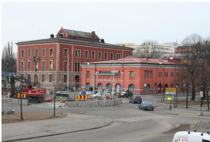
Oslo sjøtollsted sett fra Flytogsterminalen i nordøst. Foto: J. Chr. Eldal, NIKU 2008.
