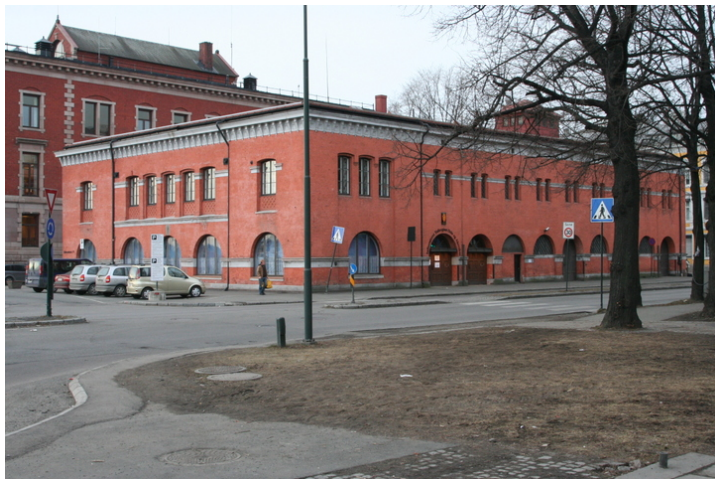
Stenpakkhuset sett fra øst. Foto: J. Chr. Eldal, NIKU 2008.
