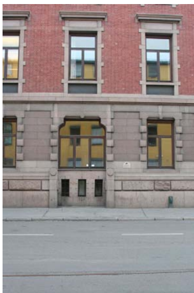
Fasaden mot Strandgata sett fra nordvest. Foto: J. Chr. Eldal, NIKU 2008.
