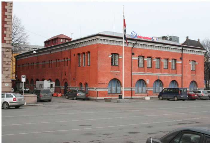
Stenpakkhuset sett fra syd. Foto: J. Chr. Eldal, NIKU 2008.
