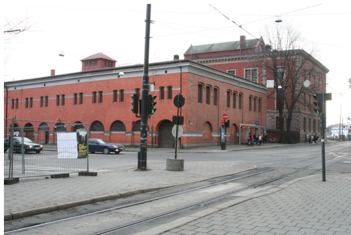
Oslo sjøtollsted sett fra Strandgata i nord. Foto: J. Chr. Eldal, NIKU 2008.
