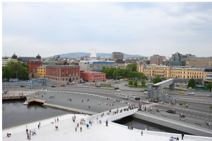
Tollstedet inngår i et viktig bygningsmiljø med Børsen i parken t.v., Oslo S t.h. og Operaen i forgrunnen. Foto: J. Chr. Eldal, NIKU 2008.
