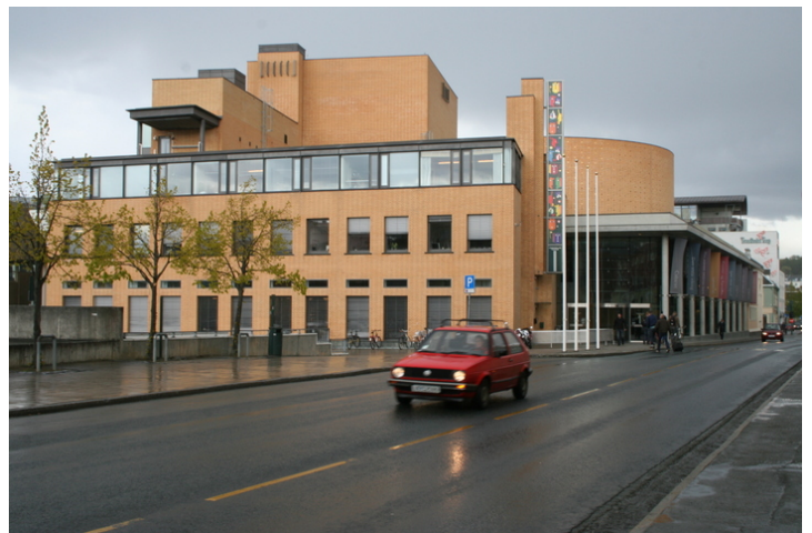
Sett fra vest langs Erling Skakkes gate med ny hovedinngang t.h. Den gamle bygningen skimtes i bakgr. t.h. Foto: J. Chr. Eldal, NIKU 2008.
