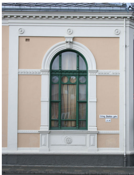
De store vinduene har fremdeles opprinnelig hovedinndeling, men nyere rammer og glass. Foto: J. Chr. Eldal, NIKU 2008.
