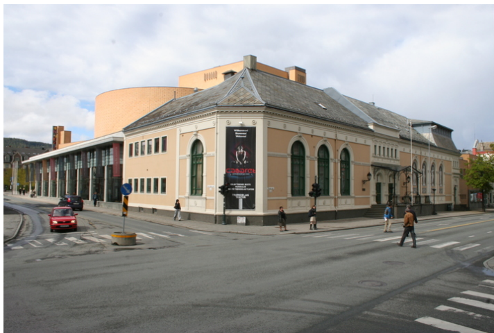
Trøndelag Teater sett fra sydøst. T.h. teatret fra 1816, i forgr. Theatercafeen fra 1860, og t.v. og i bakgr. det nye teaterbygget fra 1997. Foto: J. Chr. Eldal, NIKU 2008.
