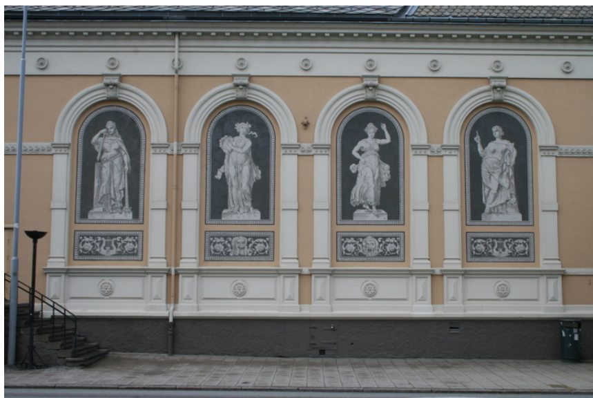
De fire muser, som trolig ble malt rett etter at fasaden var oppsatt ca 1892. Foto: J. Chr. Eldal, NIKU 2008.
