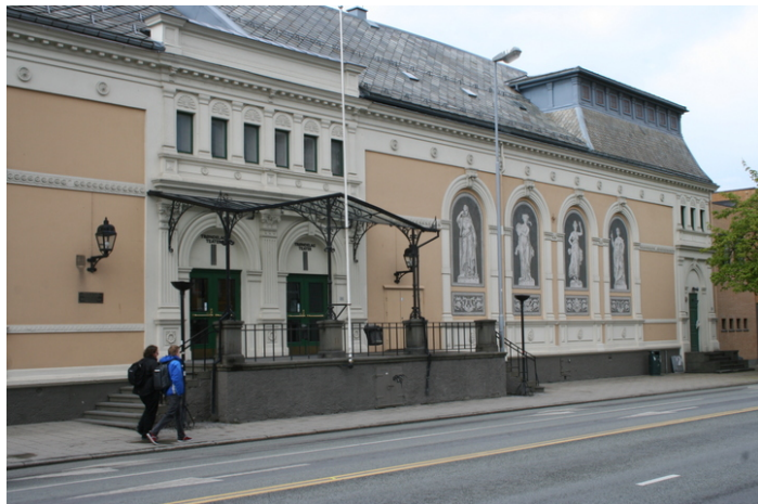
Teaterbygningen sett fra sydøst, innkledd av bygningskompleksets felles fasade fra 1890-årene. I bakgrunnen opplettet i taket for snoreloftet fra 1913-16. Foto: J. Chr. Eldal, NIKU 2008.
